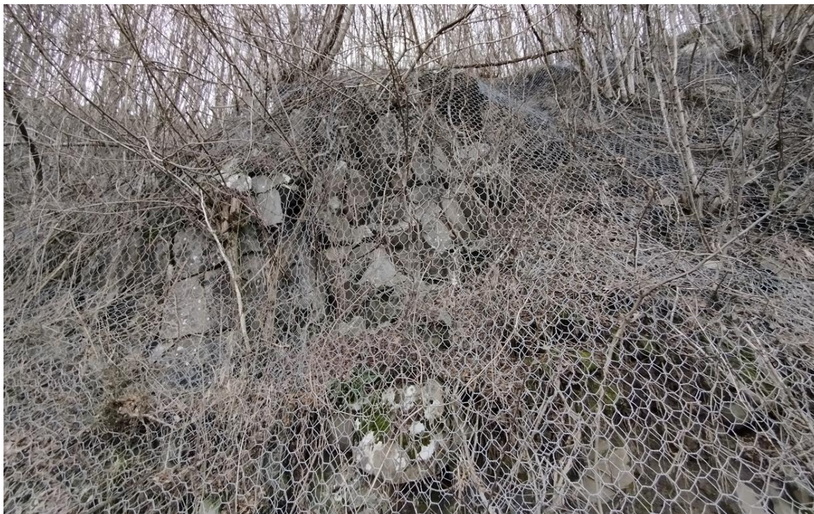
Figura 9-5: Dettaglio dello sperone roccioso sede dell'intervento Po.025-9, caratterizzato da fratturazione a spaziatura decimetrica che interessa uno spessore di circa 3 m, estruso rispetto alla topografia circostante, poggianti su una superficie a franapoggio inclinata a circa 60°, per il quale è previsto l'abbattimento mediante mezzi meccanici. Al di sotto della superficie a franapoggio viene ipotizzata la presenza di un ulteriore spessore instabile di circa 1 m.
