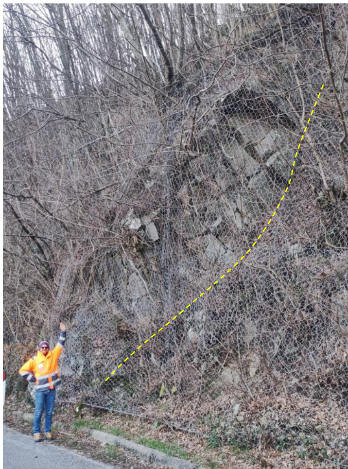
Figura 9-12: Lo sperone roccioso del Po.025-9, già illustrata nella Figura 9-5, per il quale è previsto l'abbattimento con mezzi meccanici, con evidenziata la superficie a franapoggio inclinata circa 60° che isola l'intero sperone dall'ammasso roccioso retrostante. Nel caso di una mobilitazione simultanea per scivolamento, sarebbe da attendersi un volume complessivo dell'evento di circa 80 m 3 .
