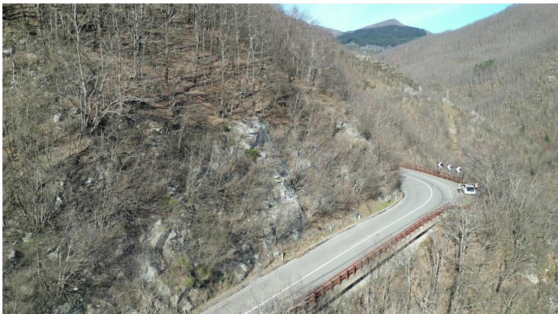
Figura 9-1: Ripresa aerea laterale della porzione meridionale della scarpata oggetto di intervento. Qui l'altezza della stessa raggiunge i 20 m circa. L'acclività, variabile, supera i 60-70° in corrispondenza dei fronti rocciosi.
