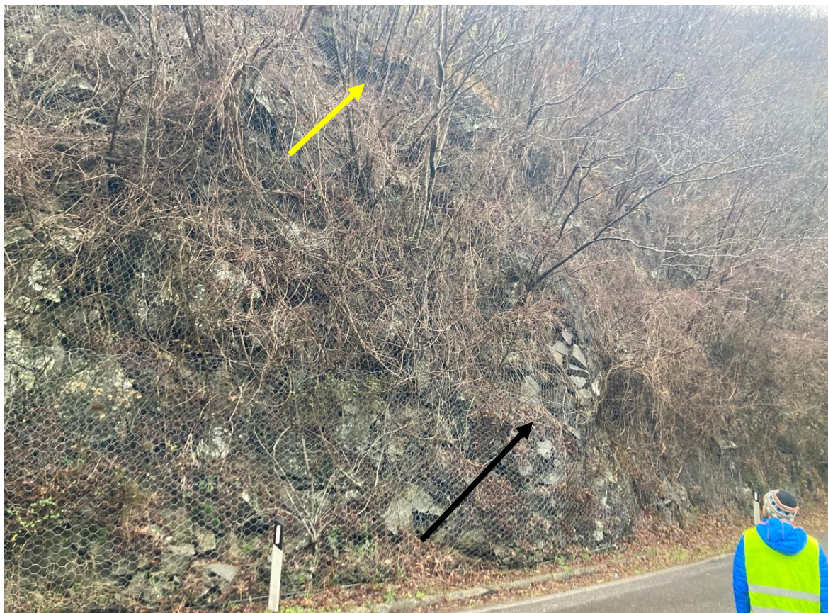
Figura 9-10: Nicchie di distacco pregresse in corrispondenza del ciglio della scarpata (freccia gialla) e conseguente riempimento detritico a tergo del rivestimento (freccia nera). In caso di cedimento della rete verrebbero mobilizzare decine di metri cubi di materiale con anche la presenza, non rara, di volumi unitari ben superiori.
