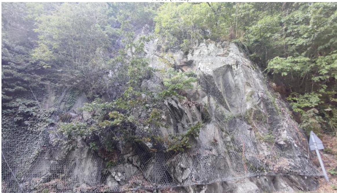
Figura 5-2. Scarpata rocciosa (FAL1) in assetto a traverpoggio. Gli strati hanno potenza pluridecimetrica (talora superiore al metro).
