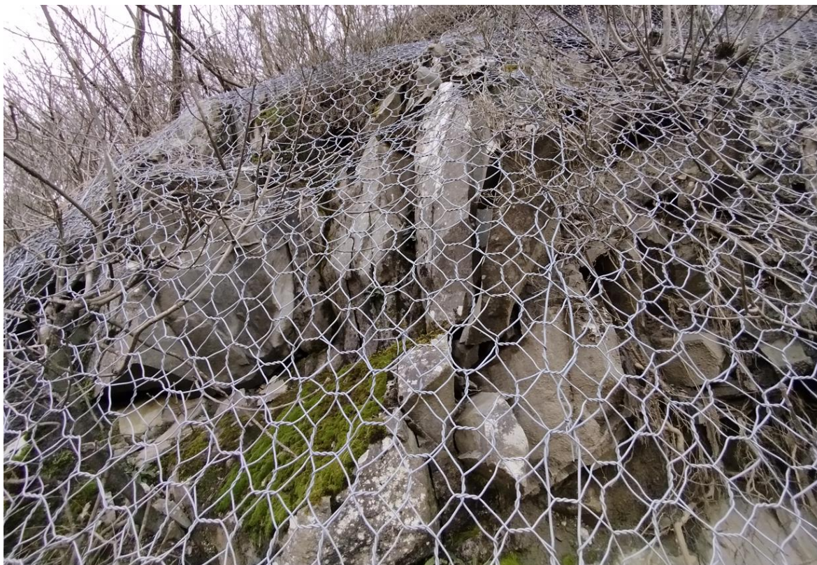
Figura 9-4: Dettaglio di un settore in cui l'ammasso roccioso è pervaso da fratturazione a spaziatura decimetrica. I blocchi unitari raggiungono al massimo poche decine di litri di volume.
