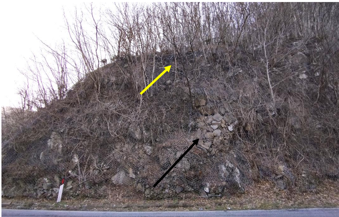
Figura 9-11: Altro esempio di nicchie di distacco pregresse in corrispondenza del ciglio della scarpata (freccia gialla) e conseguente riempimento detritico a tergo del rivestimento (freccia nera).
