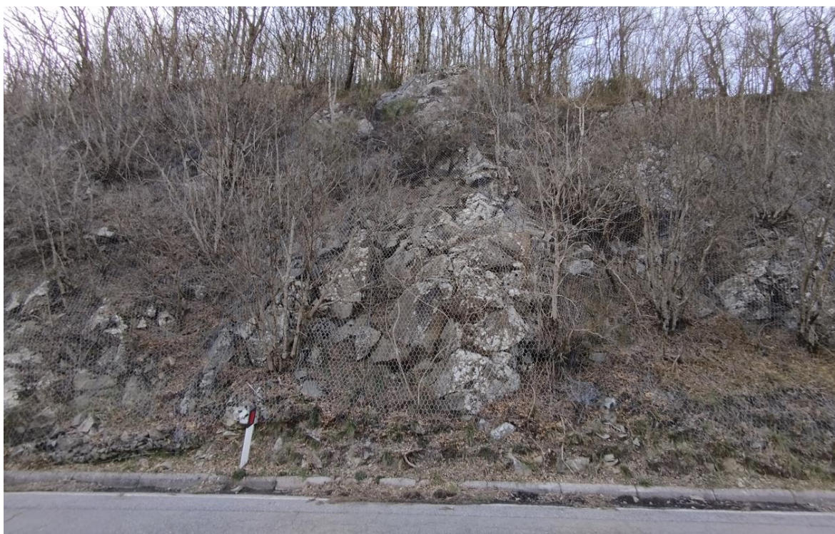
Figura 9-9: Dettaglio dello sperone roccioso oggetto dell'intervento Po.025-15. La fratturazione con spaziatura da pluridecimetrica a metrica definisce volumi unitari modali dell'ordine degli 0.2 m 3 e blocchi massimi fino a 5 m 3 . Lo spessore instabile ipotizzato è pari a 1.5 m. L'intero sperone pare svincolato dal retrostante ammasso roccioso da una superficie ad alto angolo subparallela alla scarpata.
