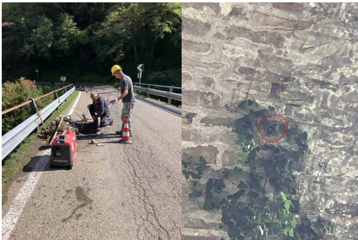
Figura 29. Esecuzione saggio e foro di uscita all'intradosso della volta.
