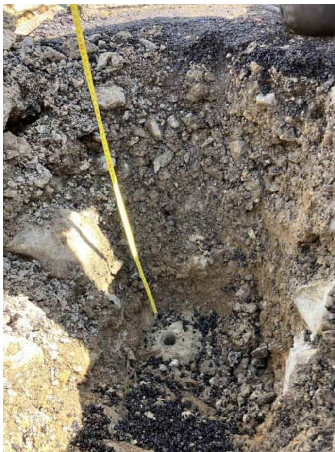
Figura 13.Scavo di altezza m0.60 e perforazione al centro volta.
