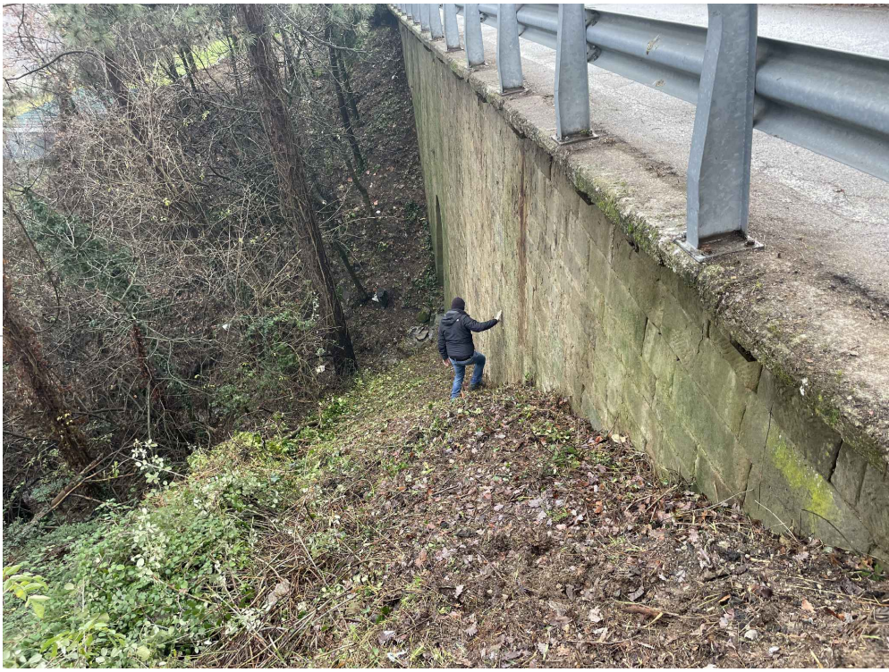
Scarpata: pendenza in corrispondenza del prospetto Est, vegetazione infestante, arbusti ed alberi d'alto fusto
