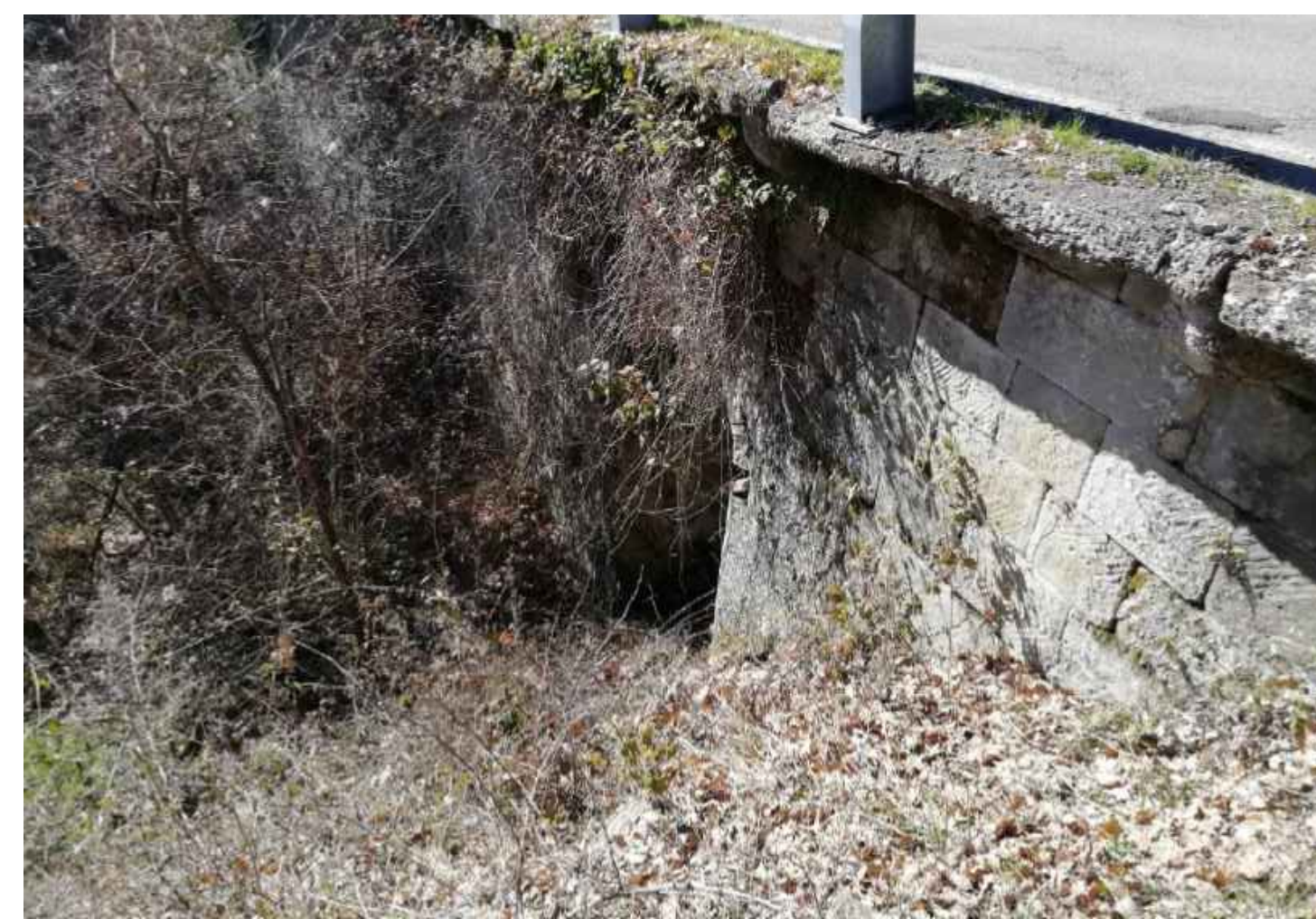
Foto n.5 - Patina biologica, polverizzazione ed efflorescenze
