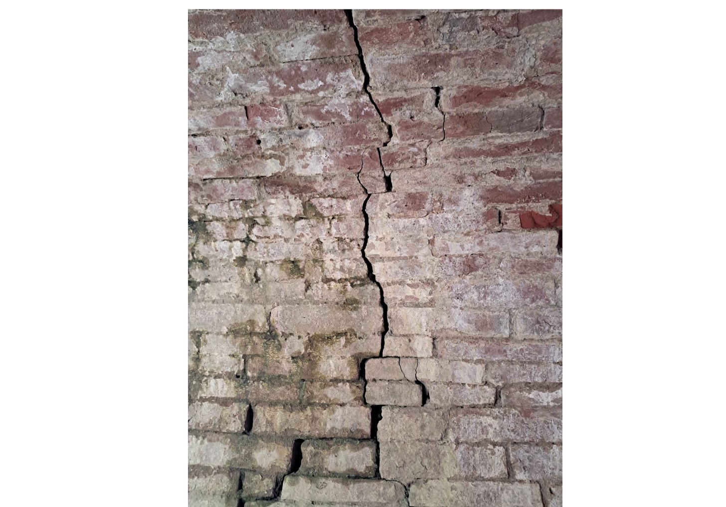
Foto n.7 - Fessure longitudinali, efflorescenze, macchie di colore scuro, patina biologica e polverizzazione
