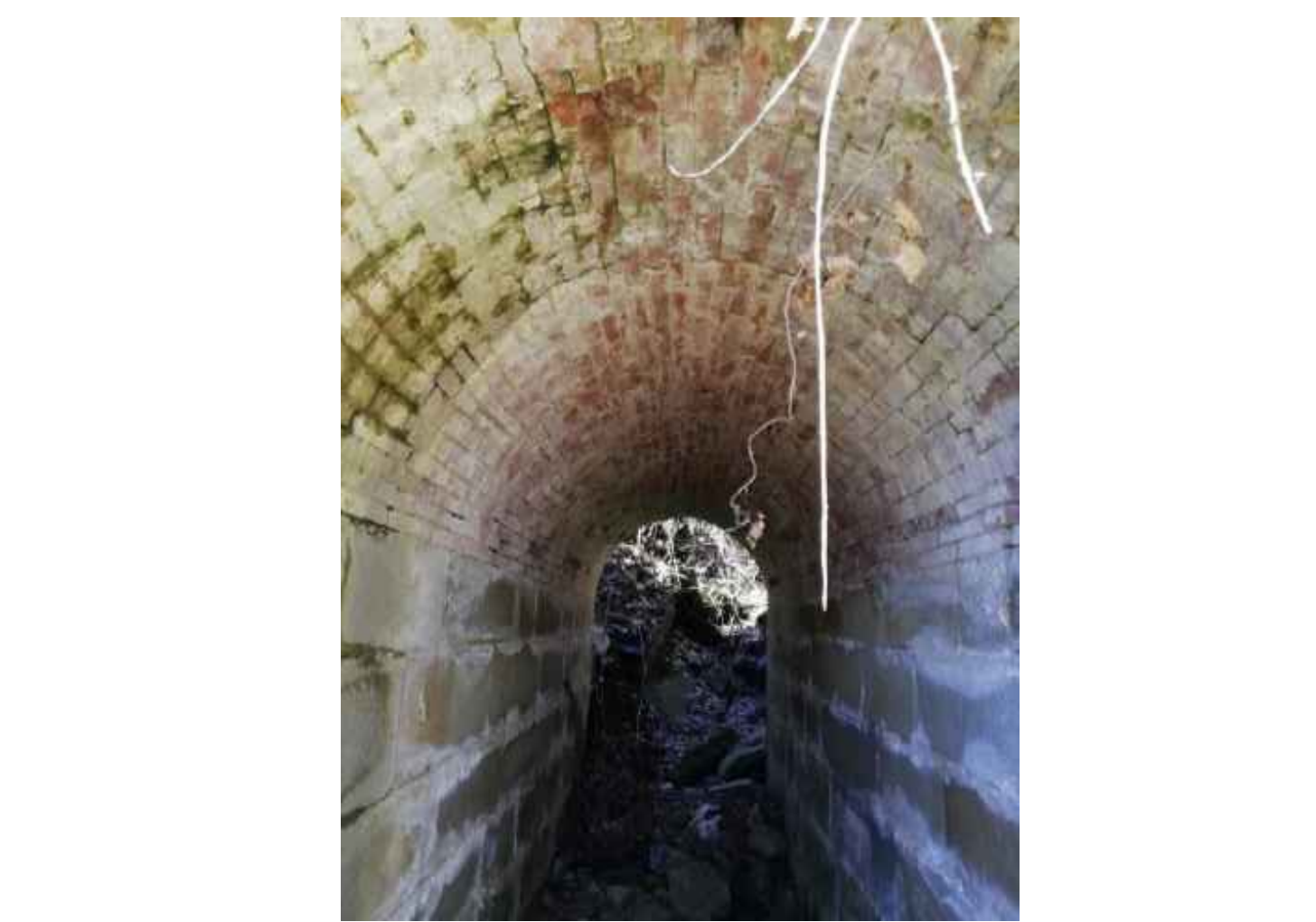
Foto n.6 - Patina biologica, esfoliazione, efflorescenze e macchie di colore scuro
