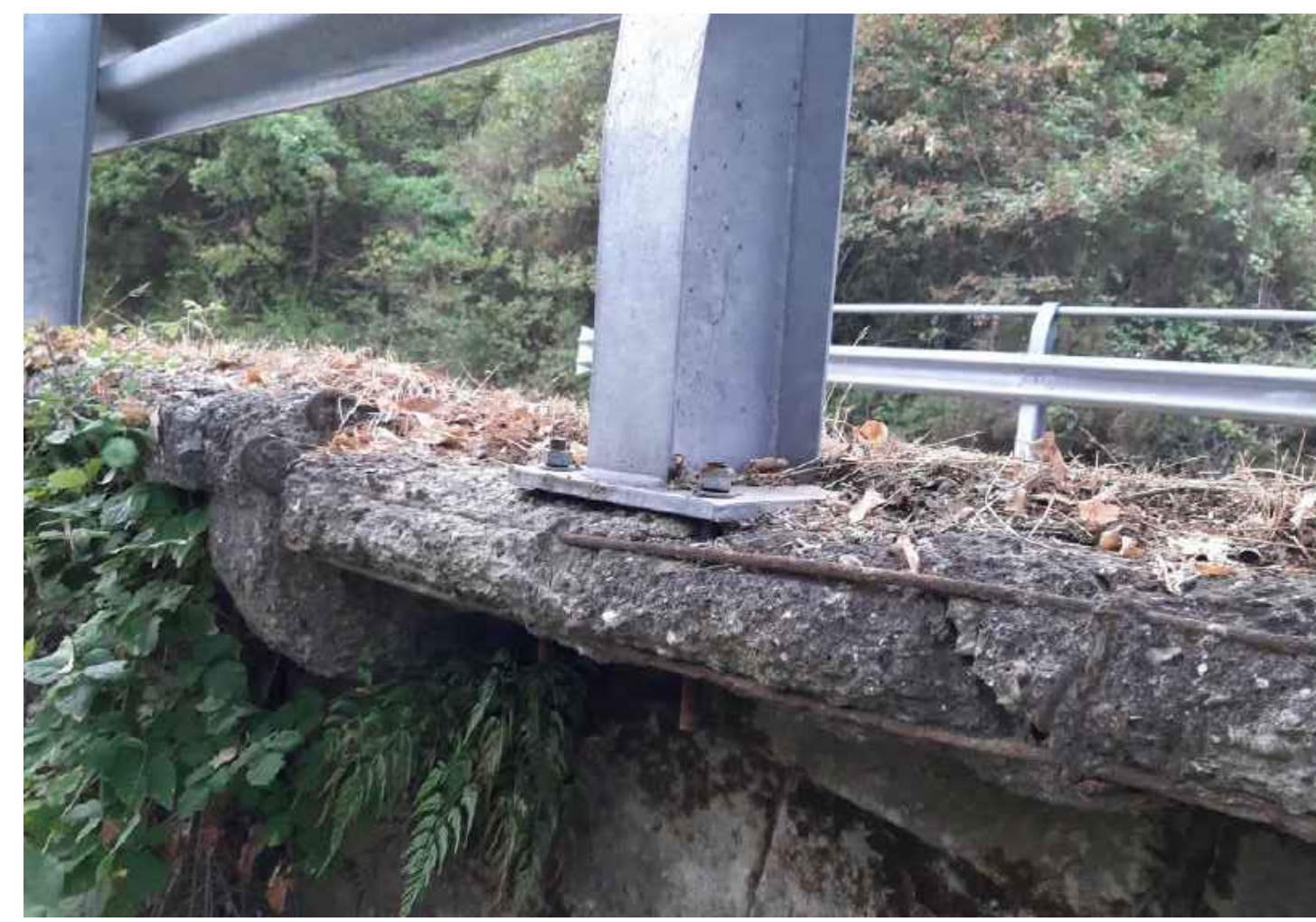
Foto n.3 - Patina biologica, fessure diagonali, distacco del coprifreno, armatura corrosa, armatura longitudinale deformata
