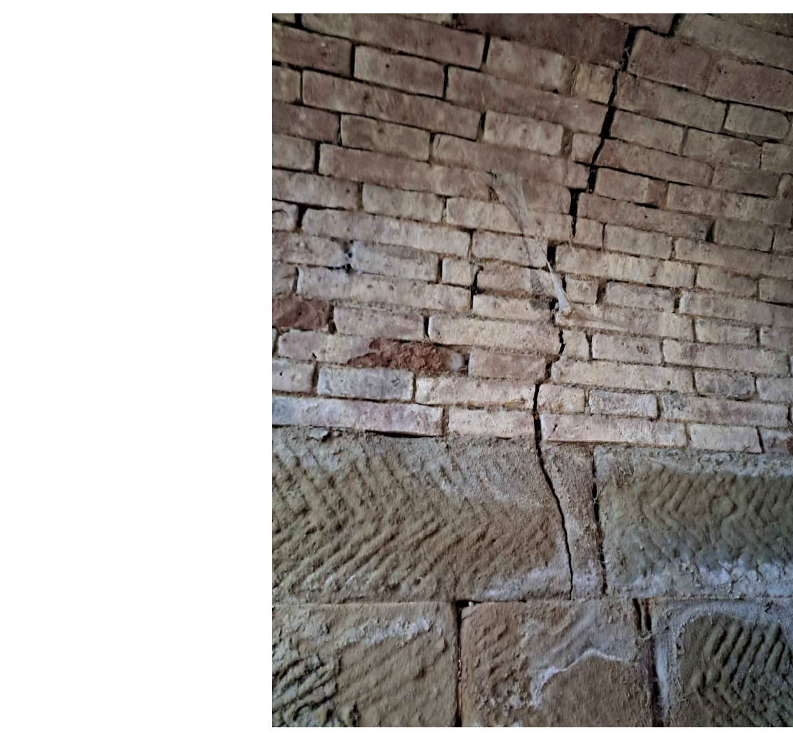
Foto n.5 - Fessure longitudinali, polverizzazione e macchie di colore scuro
