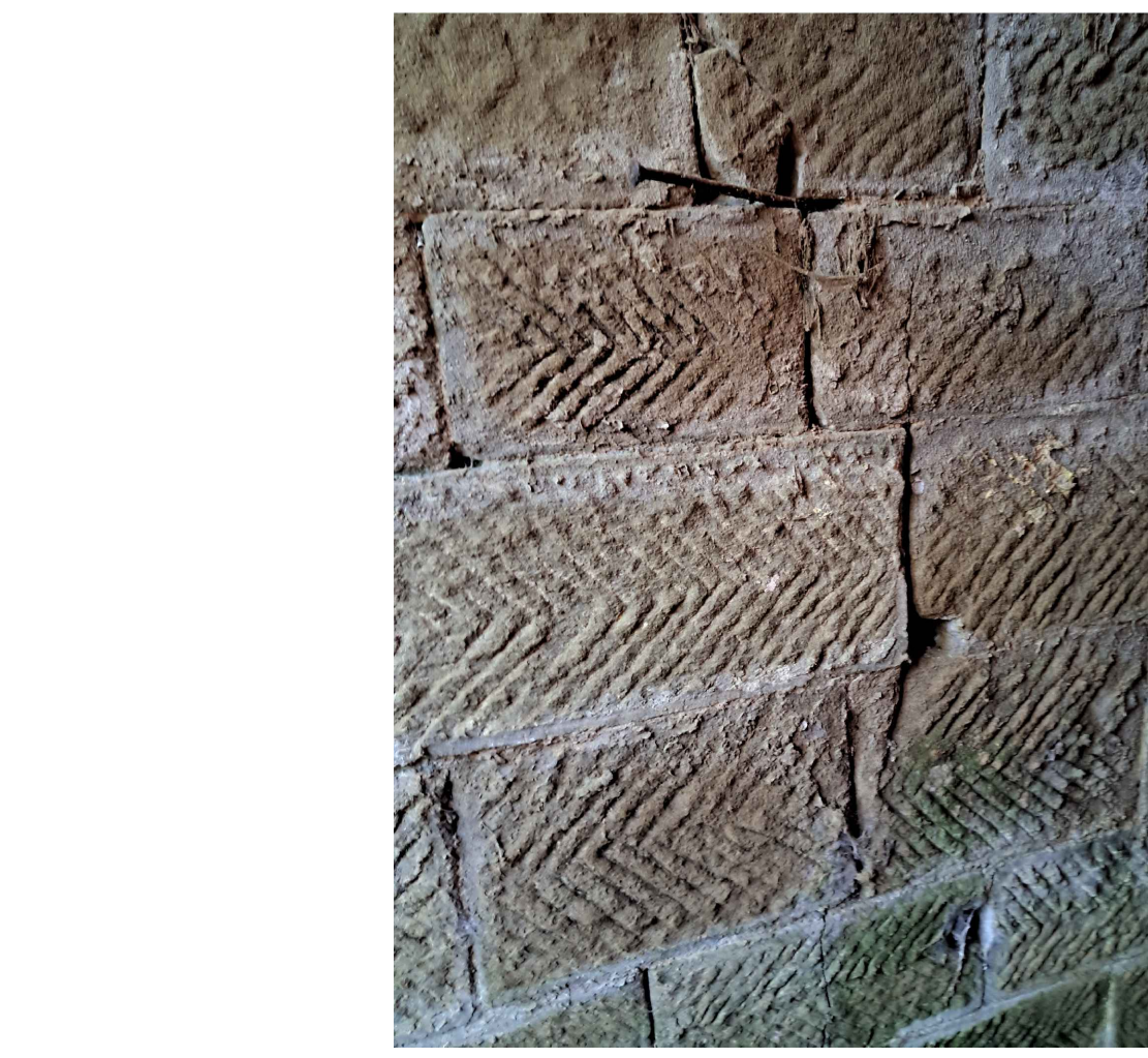
Foto n.3 - Patina biologica, efflorescenza e polverizzazione
