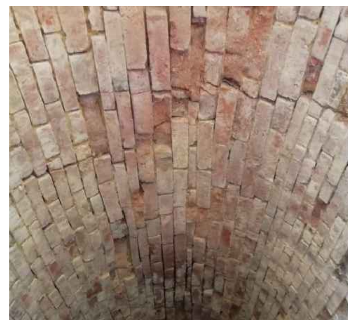
Foto n.7 - Fessure longitudinali, efflorescenze e polverizzazione
