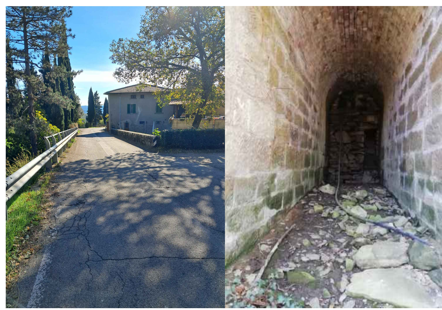
Foto n.1 - Pavimentazione stradale parzialmente dissestata
