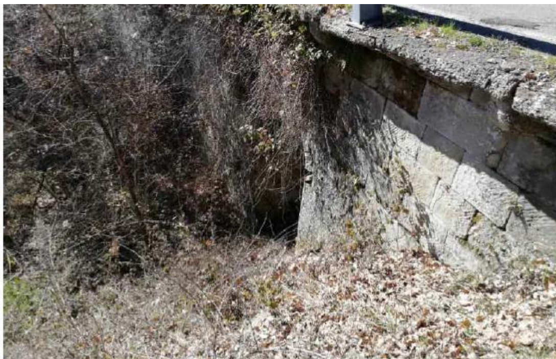
Foto n.5 - Patina biologica, polverizzazione ed efflorescenze
