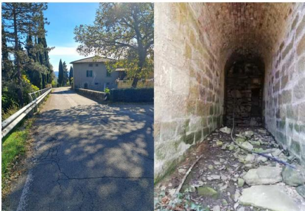
Foto n.1 - Pavimentazione stradale parzialmente dissestata
