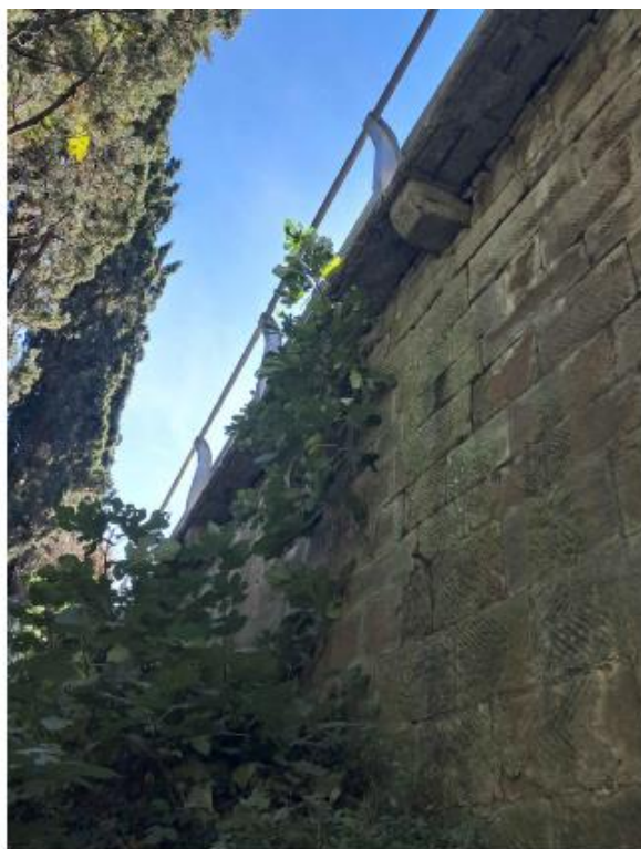
Foto n.4 - Efflorescenze, patina biologica, macchie di umidità, polverizzazione e distacco del copriferro
