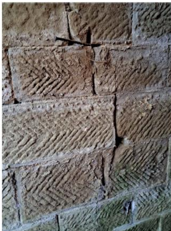
Foto n.3 - Patina biologica, efflorescenza e polverizzazione
