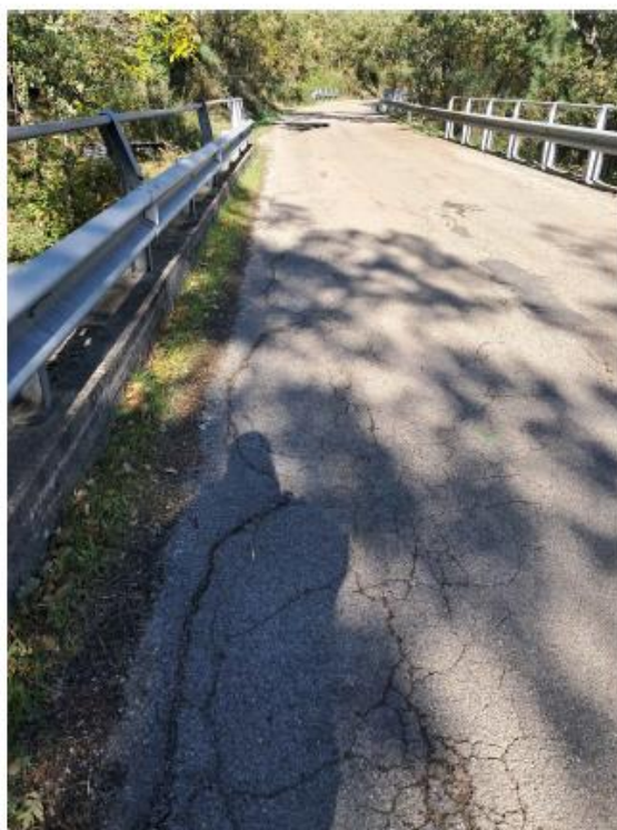
Foto n.3 - Pavimentazione stradale parzialmente dissestata
