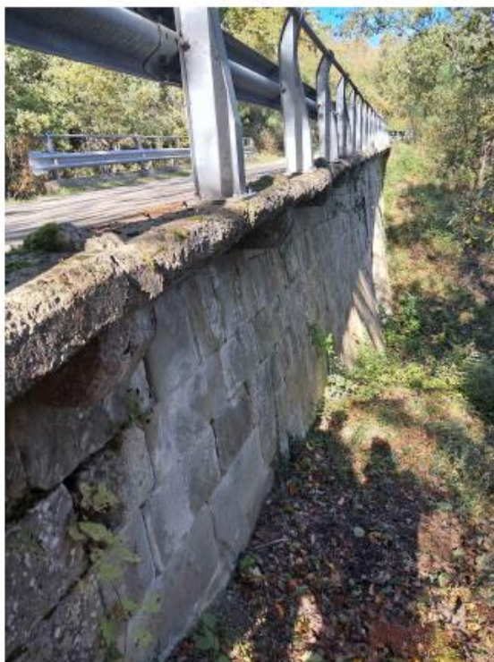
Foto n.4 - Distacco del copriferro, armatura corrosa, lesioni verticali, macchie di umidità e patina biologica
