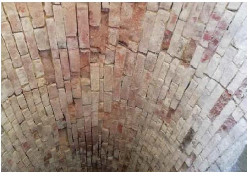
Foto n.7 - Fessure longitudinali, efflorescenze e polverizzazione
