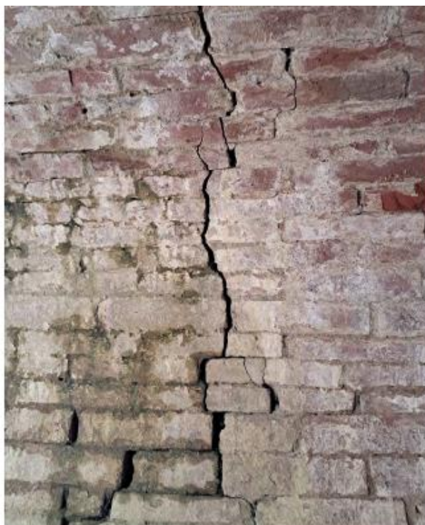
Foto n.7 - Fessure longitudinali, efflorescenze, macchie di colore scuro, patina biologica e polverizzazione
