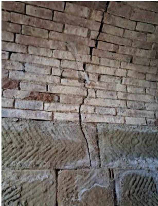
Foto n.5 - Fessure longitudinali, polverizzazione e macchie di colore scuro
