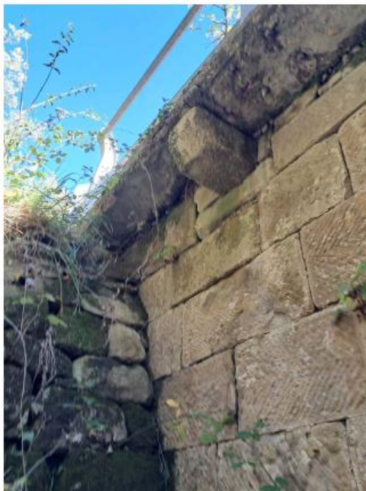
Foto n.4 - Deterioramento del copriferro del cordolo, corrosione delle barre di armatura, armatura longitudinale deformata e patina biologica
