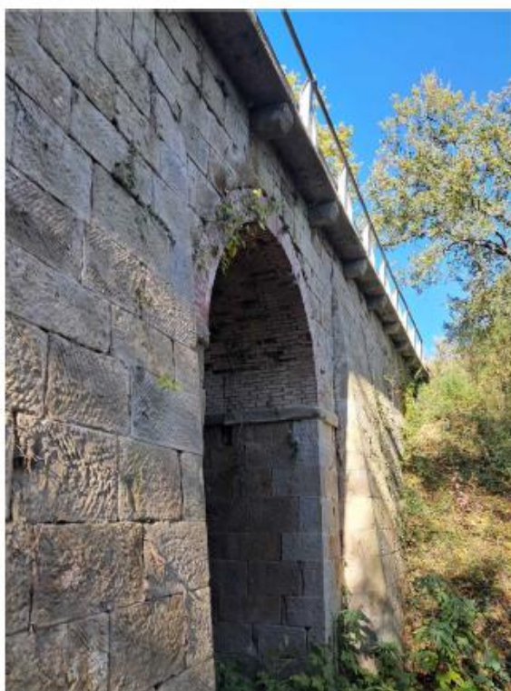
Foto n.5 - Patina biologica, efflorescenze, macchie di umidità, distacco del timpano, porzione di muratura mancante e polverizzazione
