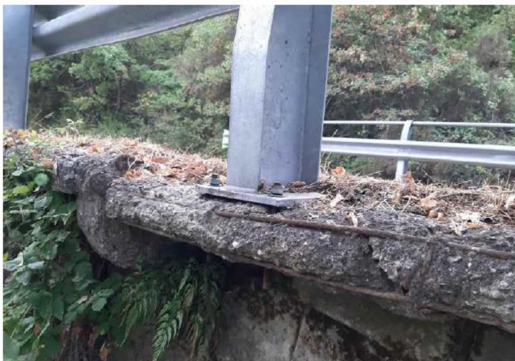
Foto n.3 - Patina biologica, fessure diagonali, distacco del copriferro, armatura corrosa, armatura longitudinale deformata
