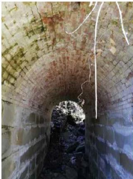
Foto n.6 - Patina biologica, esfoliazione, efflorescenze e macchie di colore scuro
