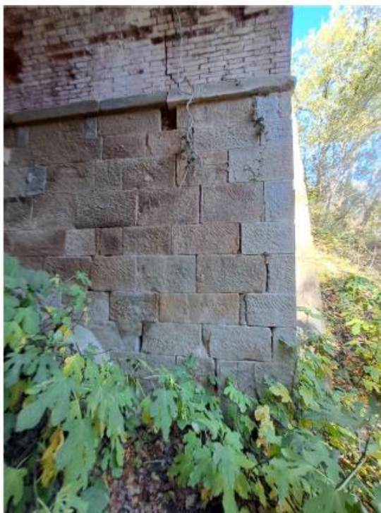
Foto n.6 - Esfoliazione, porzione di muratura mancante, patina biologica, fessure verticali, polverizzazione e vegetazione infestante
