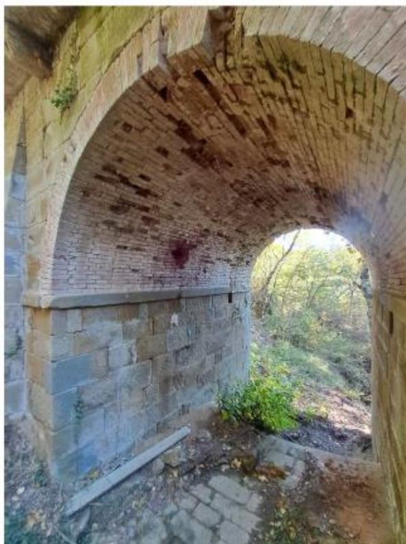
Foto n.7 - Efflorescenze, macchie di colore scuro, polverizzazione, patina biologica e porzione di muratura mancante
