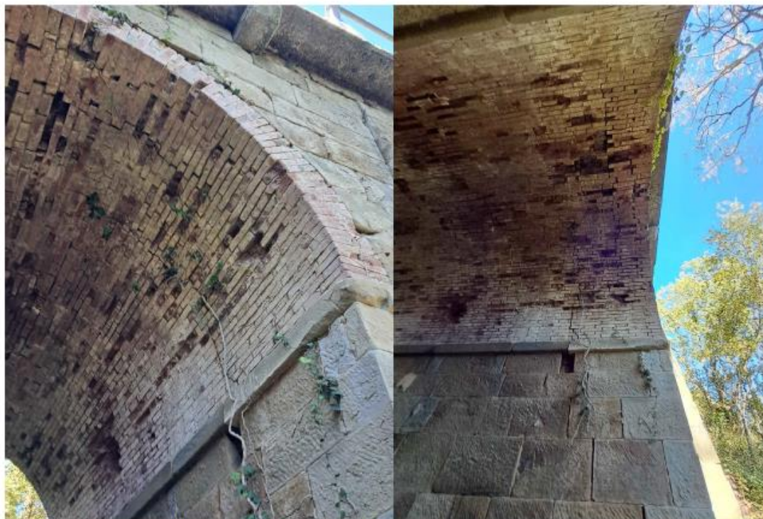
Foto n.1 - Fessura verticale significativa della volta, polverizzazione, porzione di muratura mancante, efflorescenze e patina biologica Foto n.2 - Porzione di muratura mancante, polverizzazione, efflorescenze e macchie di colore scuro
