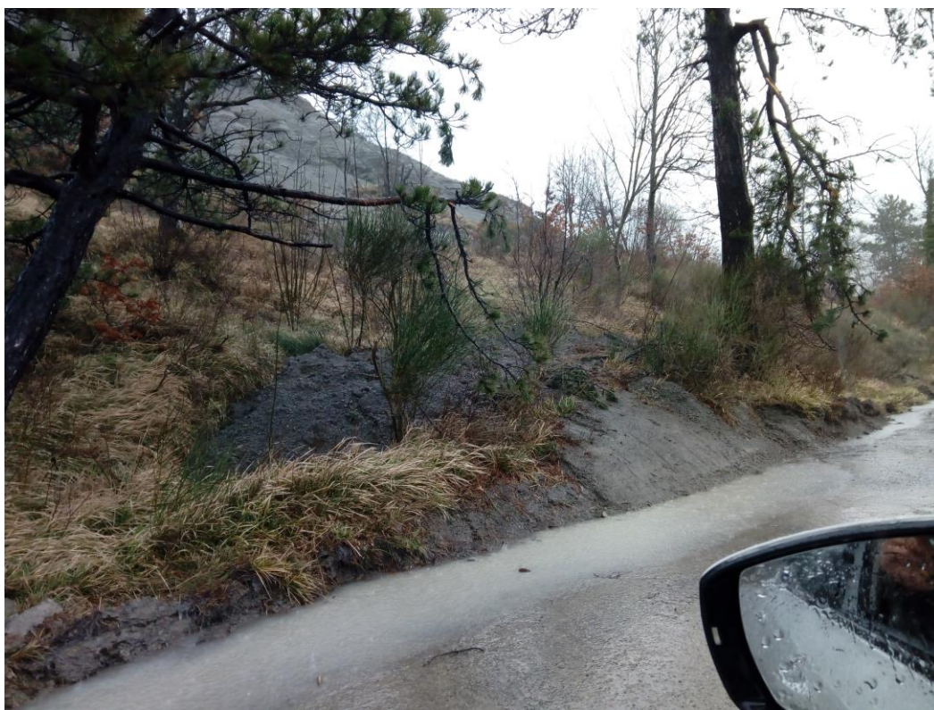
Fig. 7.5 – Versante con pendenza moderata, intorno alla progr. 4.200, caratterizzato da marne, con vegetazione rada o assente. Al piede colate di terra che giungono in banchina stradale.
