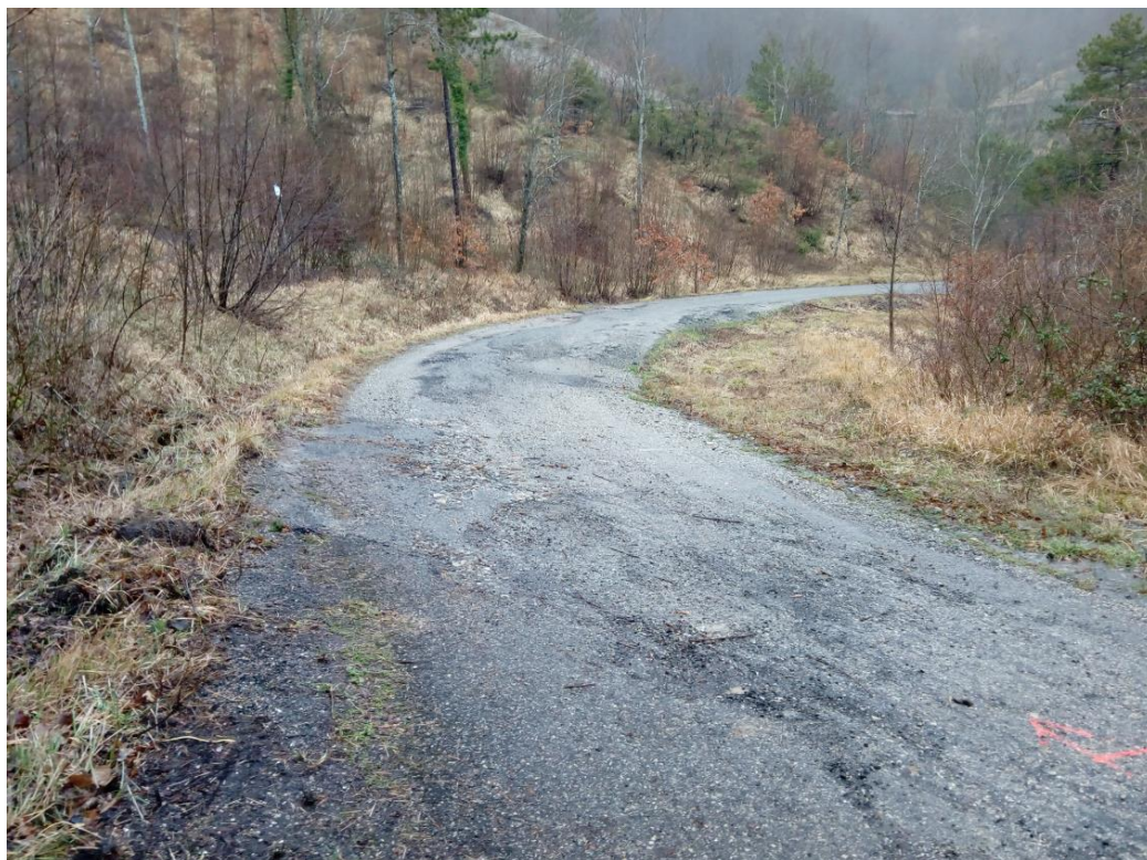
Fig. 7.4 – Abbassamento della sede stradale della S.S. 3bis, intorno alla progr. 4.500 circa, con morfologia concava verso valle per frana di scorrimento.
