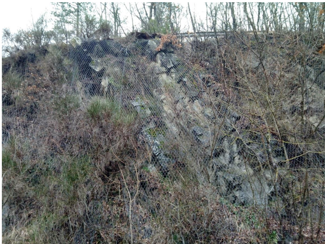
Fig. 9.12 – Rivestimento metallico su parete rocciosa - Tratto 4.
