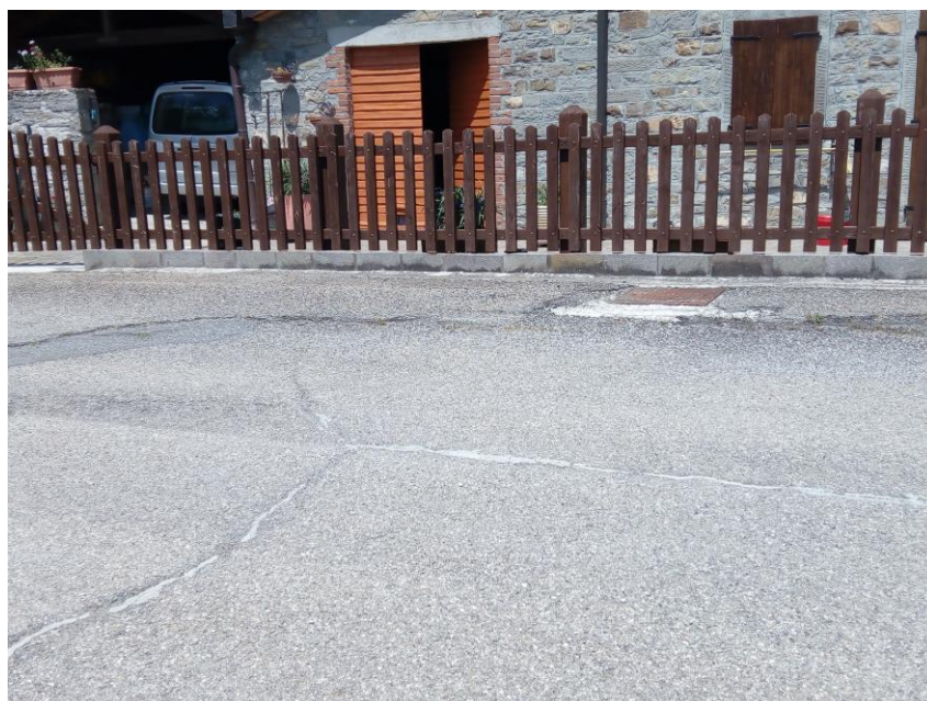
Fig. 9.8 – Particolare del dissesto sulla carreggiata lungo il Tratto 3.
