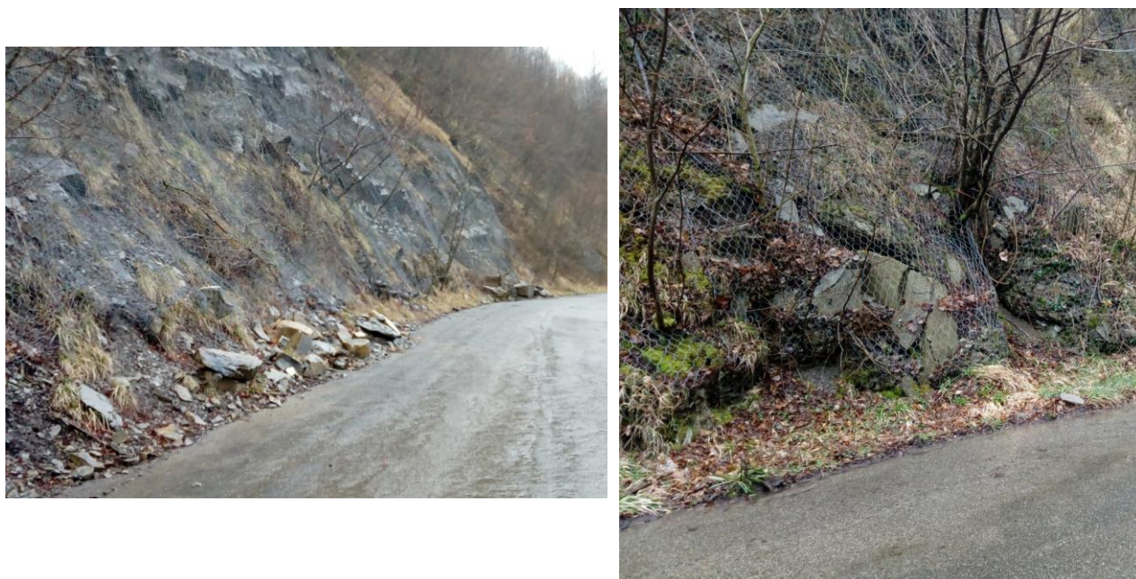
Fig. 9.28 – Rivestimenti metallici su scarpate in roccia – Tratto 10.
