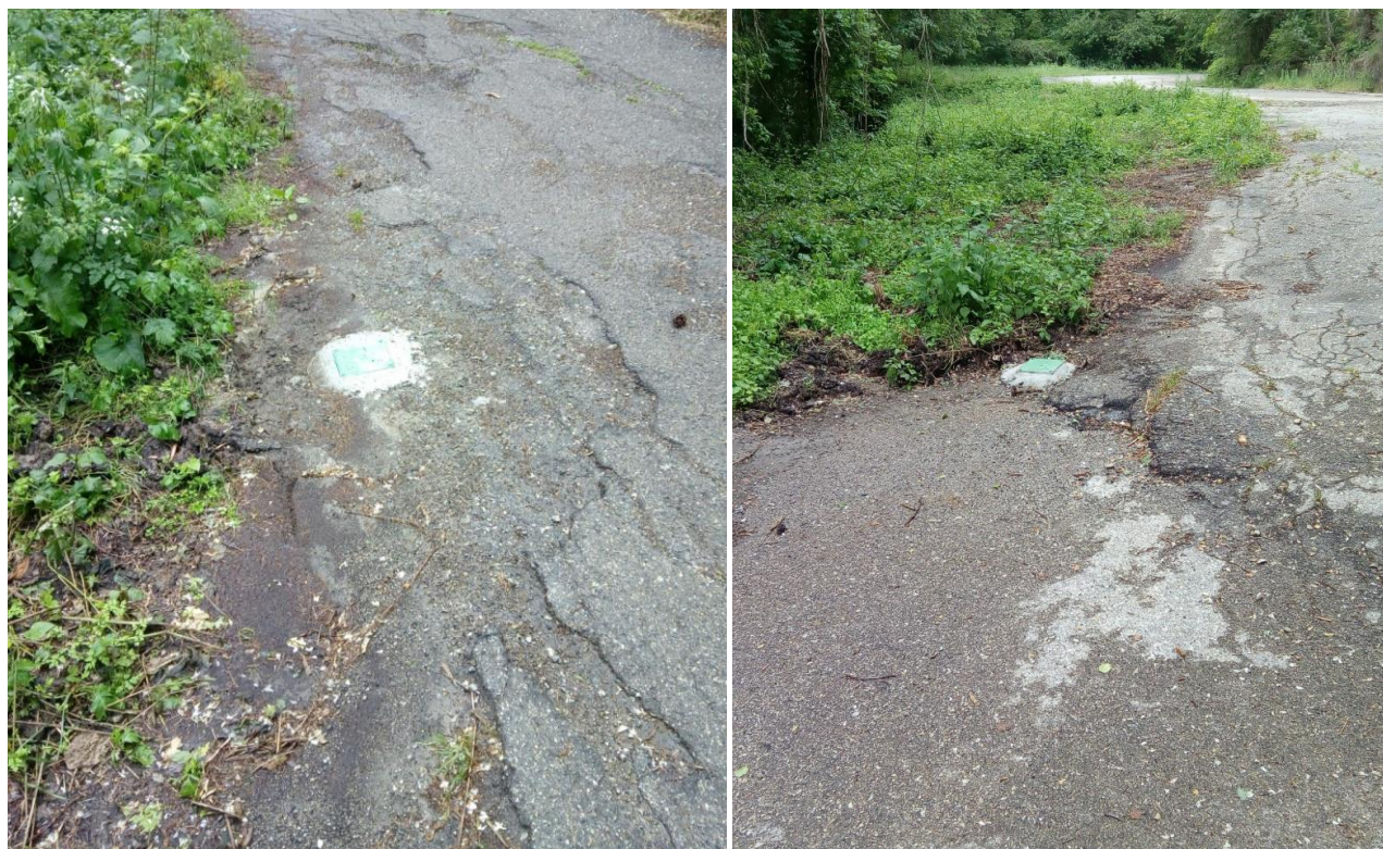
Fig. 7.8 – Pozzetti di protezione dei piezometri S7 (a sinistra) e S9 (a destra).
