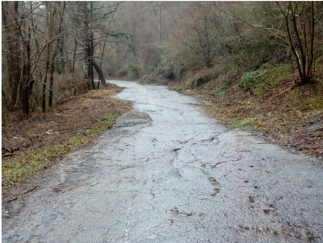
Fig. 9.37 – Dissesto con cedimento della sede stradale, Tratto 13.
