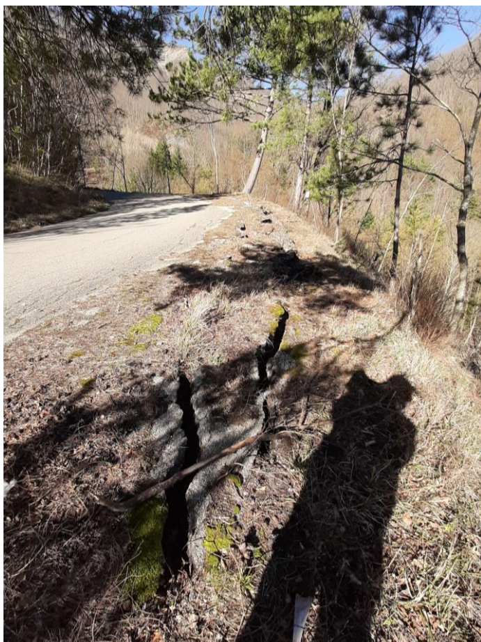
Fig. 9.27 – Fessurazioni beanti al margine della carreggiata, progr. 2.015-2.030 circa
