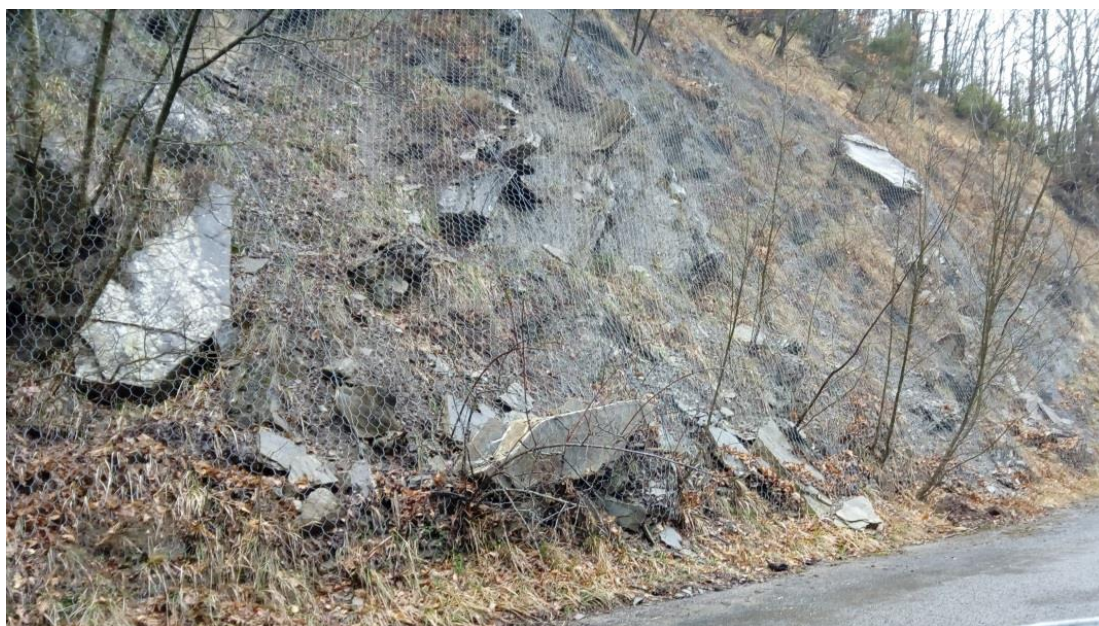
Fig. 9.20 – Rivestimento metallico su scarpata in roccia – Tratto 8.
