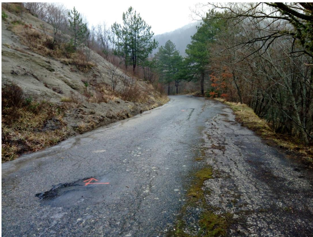
Fig. 7.3 – Abbassamento della sede stradale della S.S. 3 bis, intorno alla progr. 4.400 circa (a monte della zona di Fig. 7.2), con morfologia concava verso valle per incipiente frana di scorrimento. A monte della strada smottamenti di detrito terroso dal versante caratterizzato da marne siltose prevalenti del membro di Montecoronaro (FMA6).
