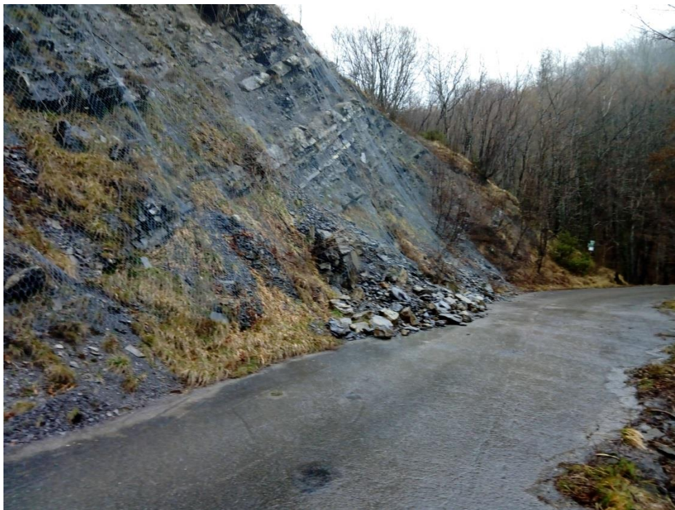
Fig. 9.32 – Rivestimenti metallici su scarpate in roccia – Tratto 12, progr. 2.426-2.444.
