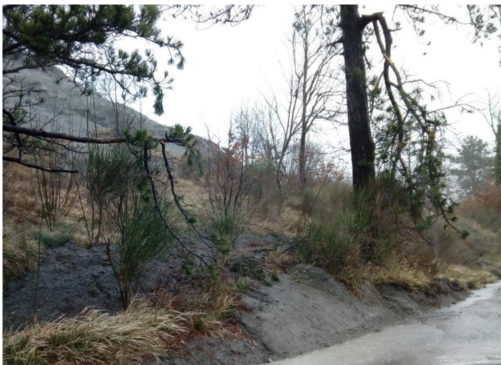
Fig. 9.50 – Fenomeno di colamento del detrito di marna nel corso di periodi con abbondanti afflussi meteorici, progr. 4.200-4.250, Tratto 15
