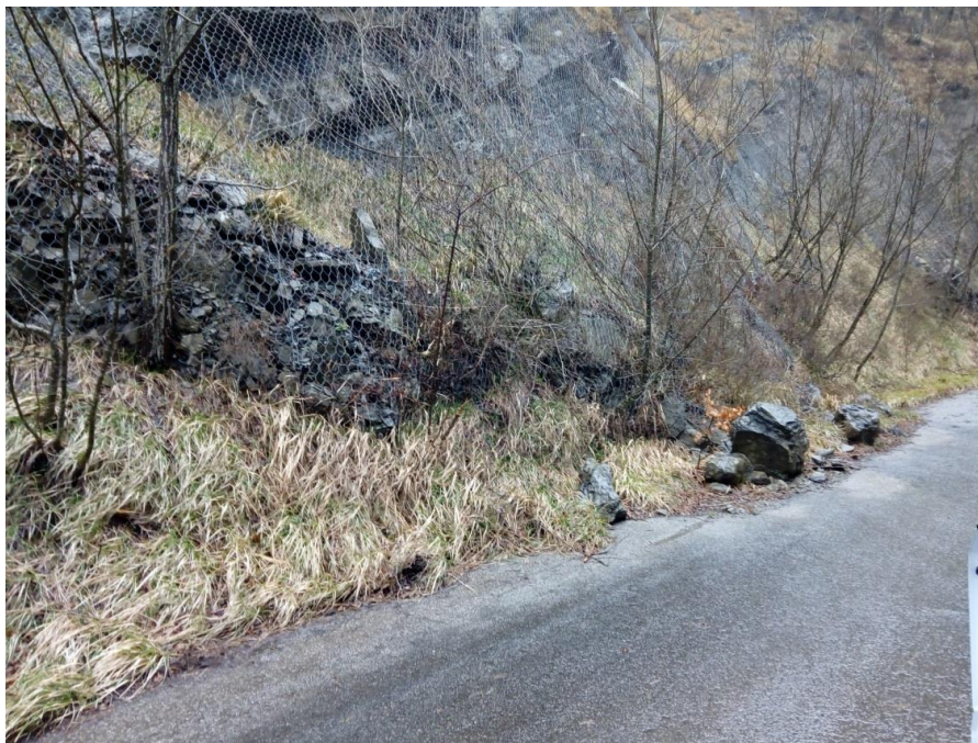
Fig. 9.33 – Rivestimenti metallici su scarpate in roccia – Tratto 12, progr. 2.584-2.708.
