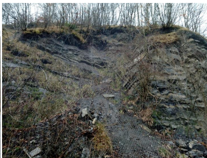
Fig. 9.31 – Rivestimenti metallici su scarpate in roccia – Tratto 12, progr. 2.250-2.236.
