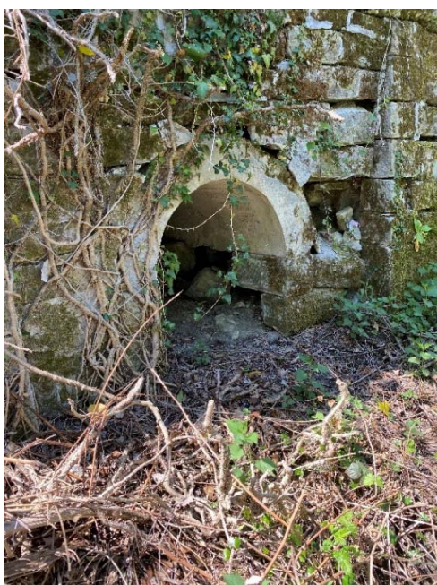
Fig. 4 - Tombino con degrado della struttura
