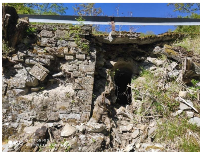
Fig. 3 -Danneggiamento del tombino dovuto a danneggiamento da radici della vegetazione e crollo
