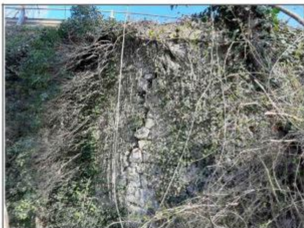
Cono ottico 8 - MURO D'ALA- Lesione verticale ed infestazione della muratura da parte della vegetazione
