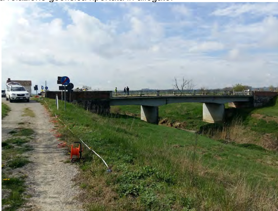
Dettaglio fotografico dell'esecuzione della prova MASW
