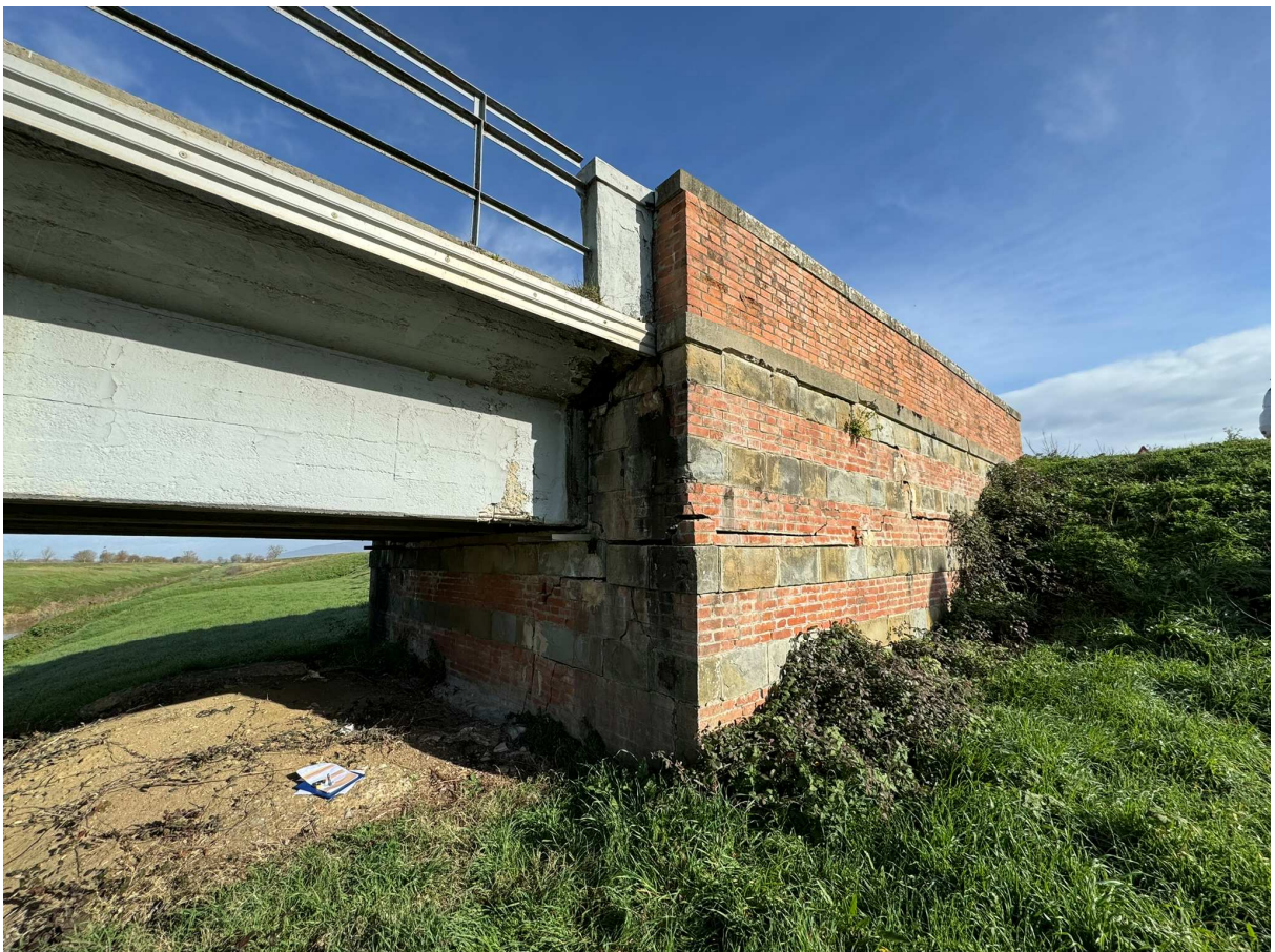
Foto della spalla lato Foiano della Chiana
