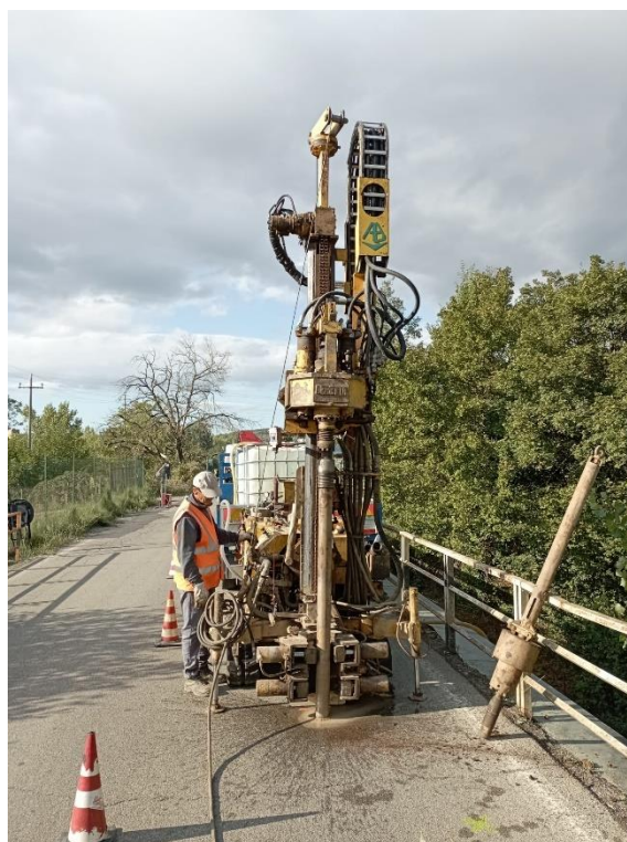
Fase di esecuzione
