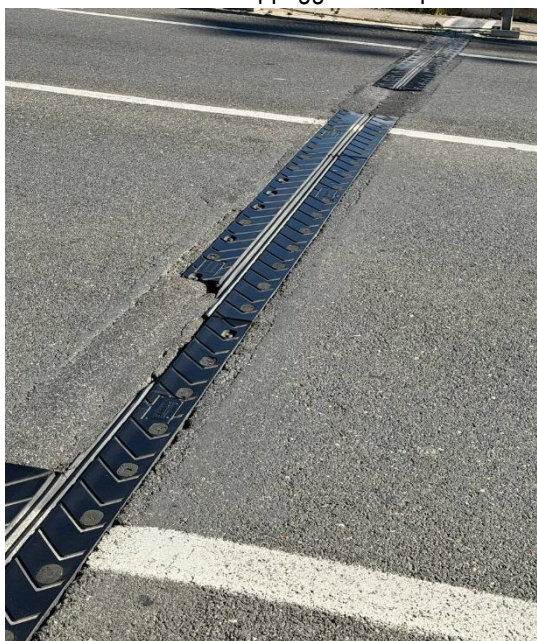
Figura 8: Giunto su pila 3
