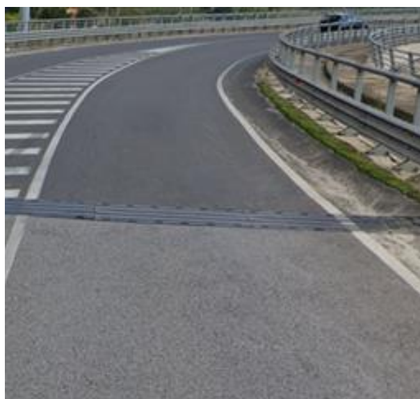
Figura 11: Giunto su spalla 2
