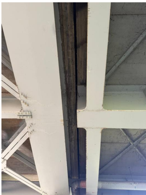
Figura 12: Vista intradosso giunto di dilatazione Pila 3
