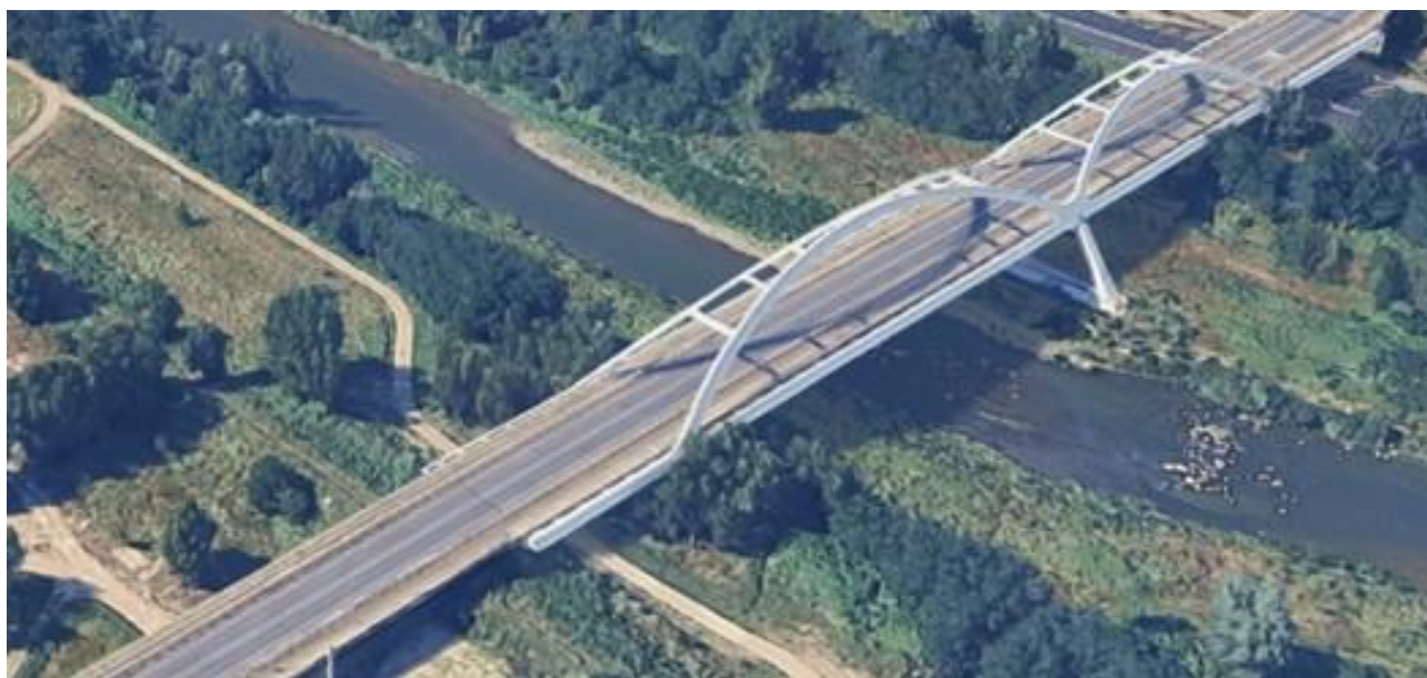
Figura 1. Ponte Leonardo, foto da Google Maps.
