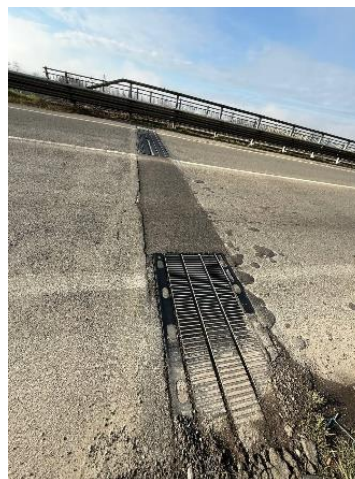
Figura 7: Giunto su spalla 2
