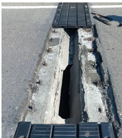
Figura 6: Giunto su spalla 2
