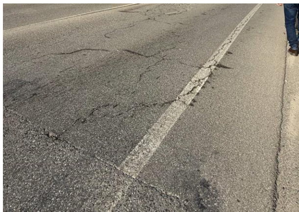
Figura 11: Pavimentazione deteriorata
