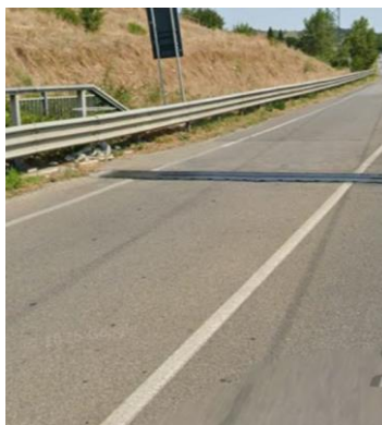
Figura 10: Giunto su spalla1
