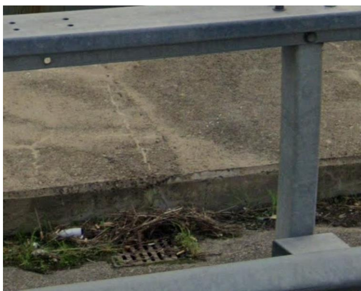
Figura 7: Stato attuale delle caditoie grigliate
