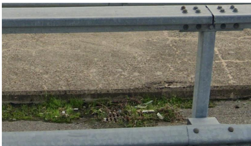
Figura 7: Stato attuale delle caditoie grigliate
