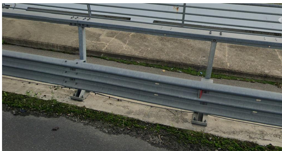
Figura 11: Stato attuale di ristagno di acqua con conseguente crescita di vegetazione
