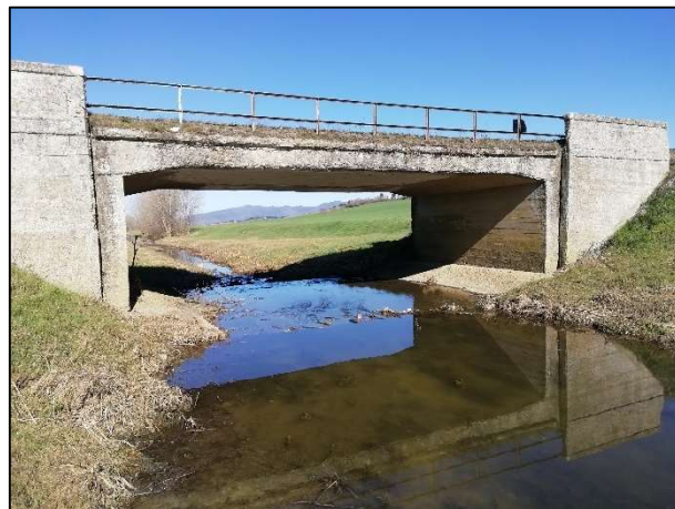
Foto 2 Prospetto laterale spalle ed impalcato
