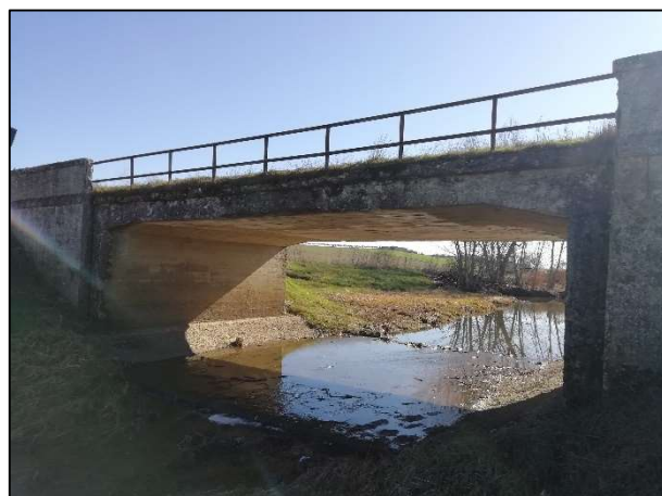
Foto 4 Prospetto laterale spalle ed impalcato
