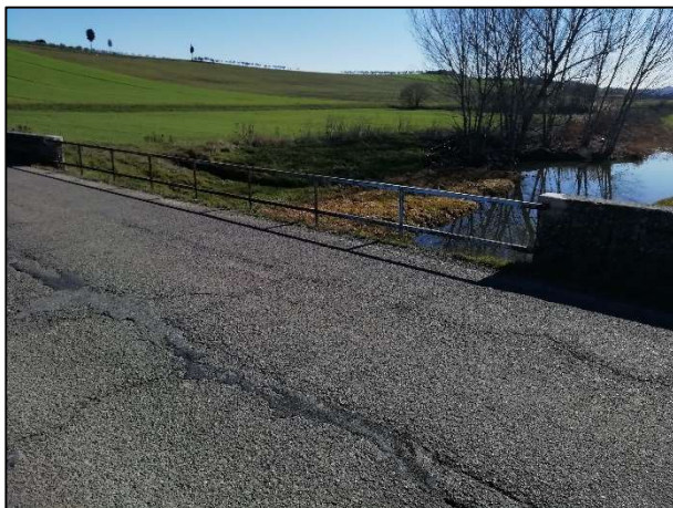
Foto 7 Stato di fatto barriera di sicurezza laterale su corsia dir. Brollo
