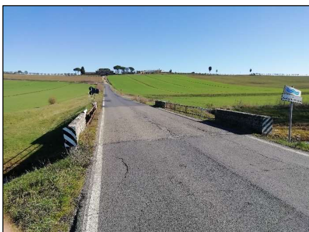
Foto 5 Stato di fatto pavimentazione stradale e barriere di sicurezza dir. Brolio
