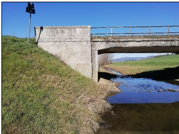
Foto 1 Prospetto laterale spalla dir. Brolio e porzione impalcato
