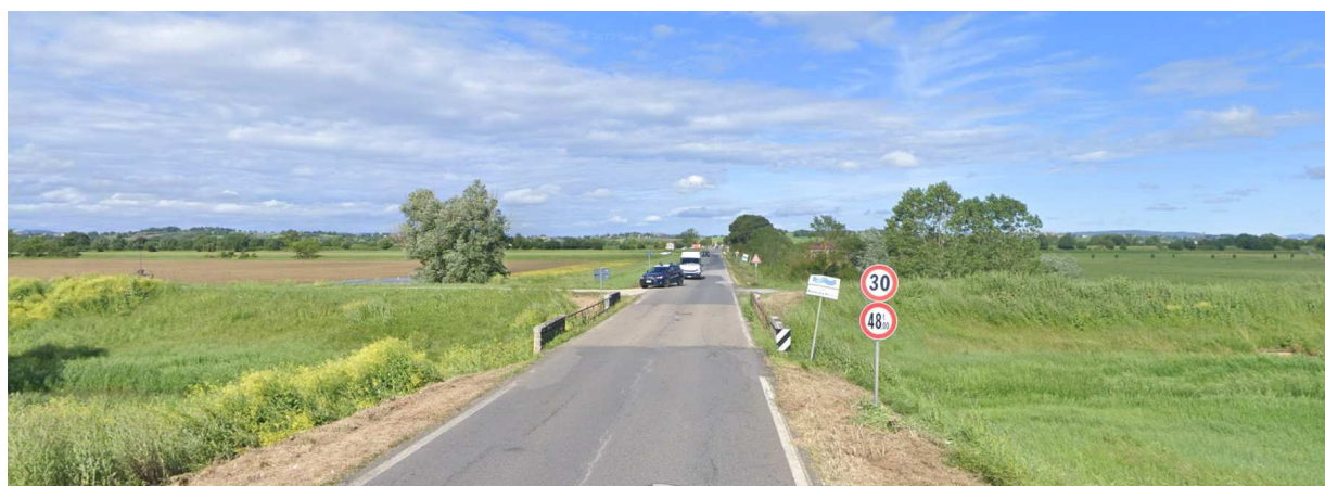
Figura 1.2 – Ponte su S.P. 27 - Vista in direzione Cesa
