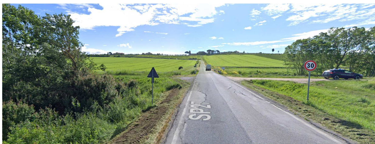
Figura 1.3 – Ponte su S.P. 27 - Vista in direzione Brolio
