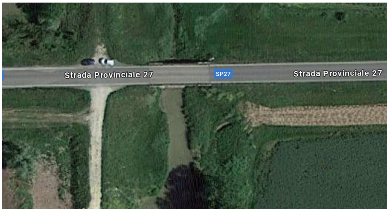
Figura 1 Ripresa fotografia aerea del ponte
