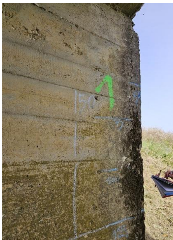
FOTO 2 - SPALLA LATO CESA PROSPETTO NORD
