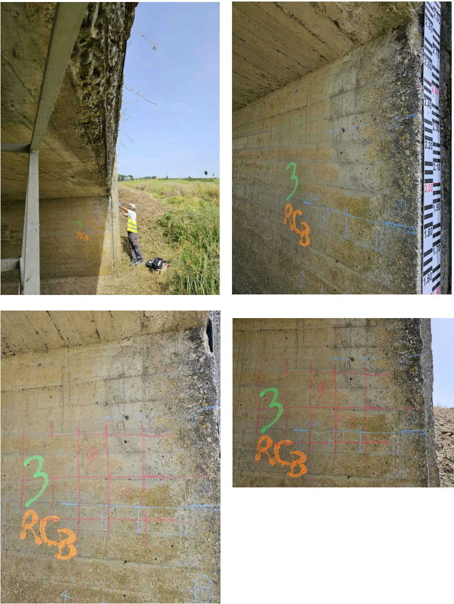
Posizione delle armature tracciate in sito durante le indagini georadar per il posizionamento ottimale dei carotaggi
