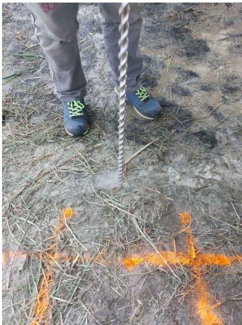
Realizzazione del foro
