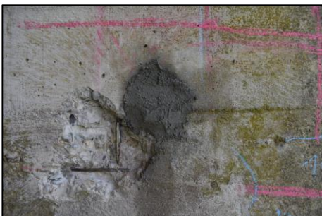
Preparazione, esecuzione e ripristino della prova.
