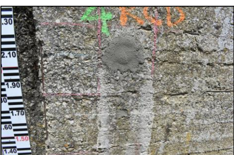
Preparazione, esecuzione e ripristino della prova.
