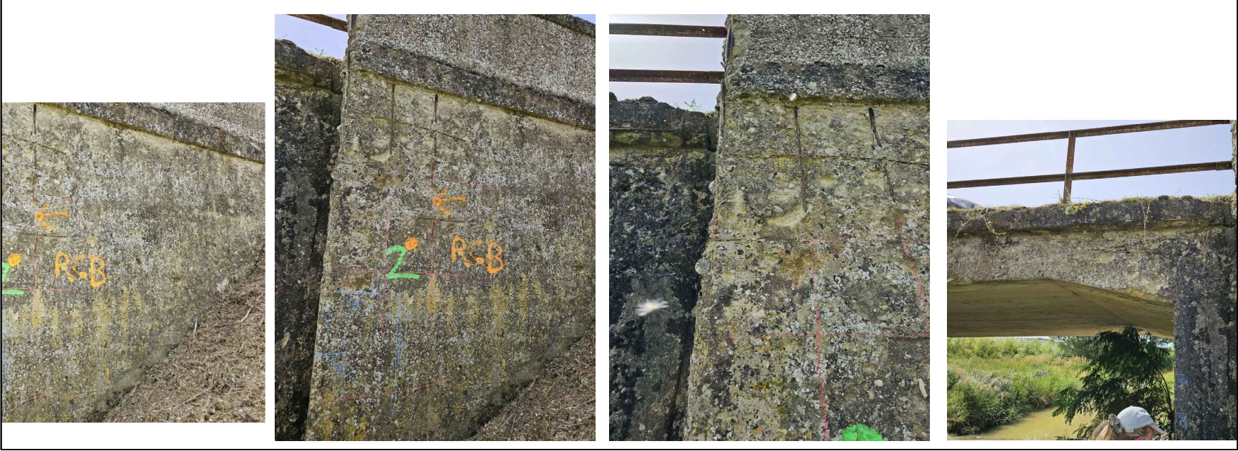
Posizione delle armature tracciate in sito durante le indagini georadar per il posizionamento ottimale dei carotaggi
