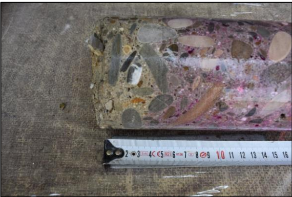
Misure dello strato di calcestruzzo carbonatato.
