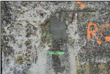
Preparazione, esecuzione e ripristino della prova.
