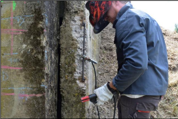
Preparazione, esecuzione e ripristino della prova.
