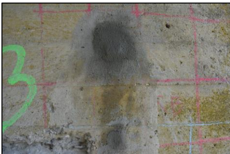
Preparazione, esecuzione e ripristino della prova.
