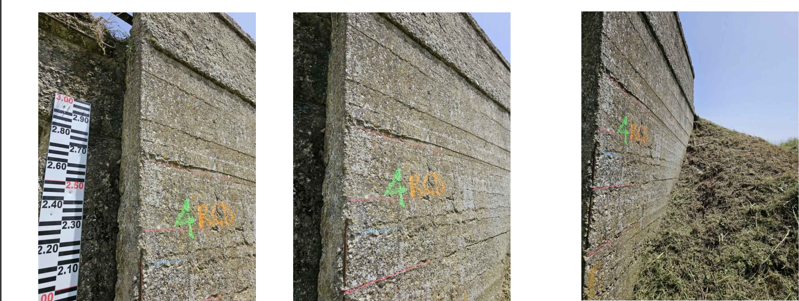
Posizione delle armature tracciate in sito durante le indagini georadar per il posizionamento ottimale dei carotaggi
