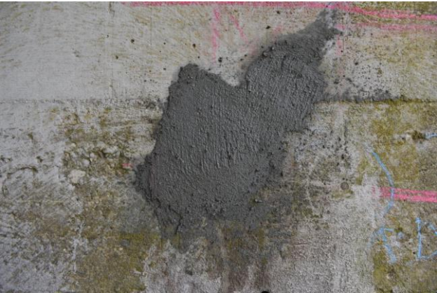
Preparazione, esecuzione e ripristino della prova.
