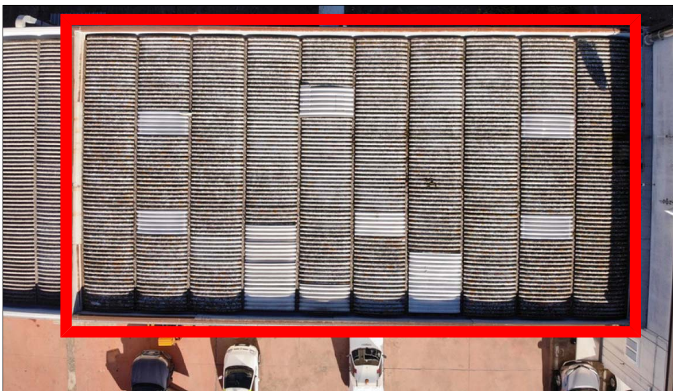
5 FOTO DALL'ALTO DELLA COPERTURA IN AMIANTO OGGETTO DI RIMOZIONE E BONIFICA A01 NO SCALA
