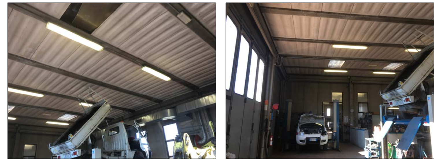
8 PARTICOLA TRAVE COPERTURA IN CAP - STATO ATTUALE NO SCALA
