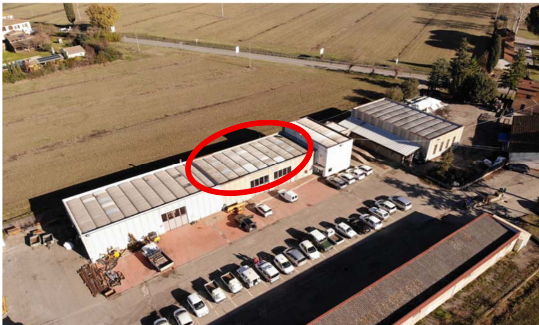
Figura 2 –Identificazione della copertura con materiale contenente amianto oggetto di rimozione e sostituzione
