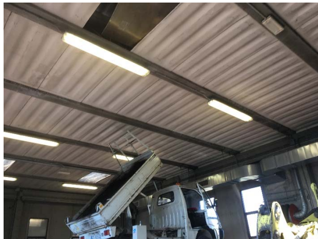
Foto della sottocopertura interna in lastre in lastre piane nervate in materiale contenente amianto
