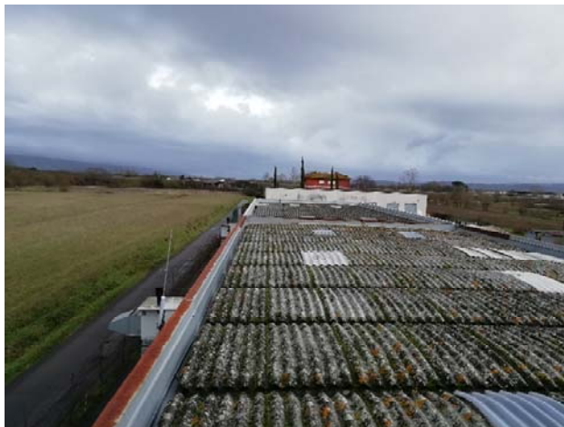
Foto della copertura esterna in lastre ondulate curve in materiale contenente amianto e del materassino sottostante
