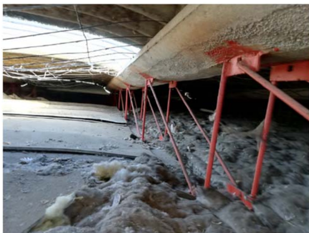
Foto delle travi ad Y tipo “P1 di Baraclit e delle lastre copertura in materiale contenente amianto
