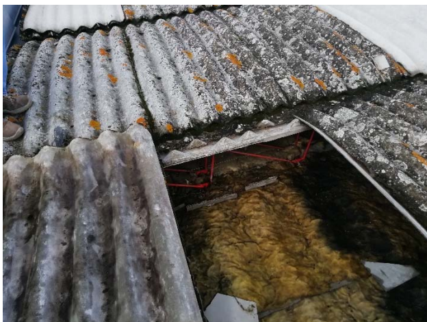
Foto della copertura esterna in lastre ondulate curve in materiale contenente amianto e del materassino sottostante
