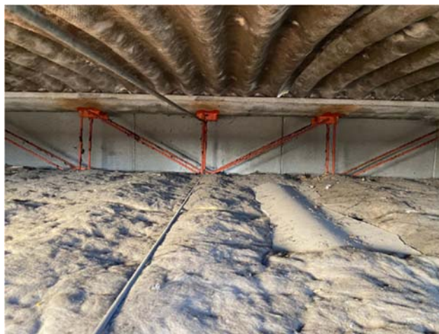
Foto delle travi ad Y tipo “P1 di Baraclit e delle lastre copertura in materiale contenente amianto
