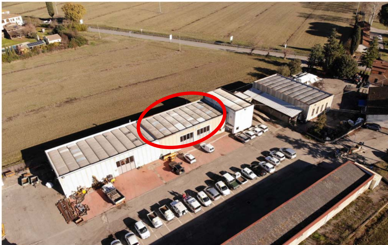
Figura 2 – Autoparco della Provincia in via Casentinese con identificazione della copertura oggetto di valutazione
