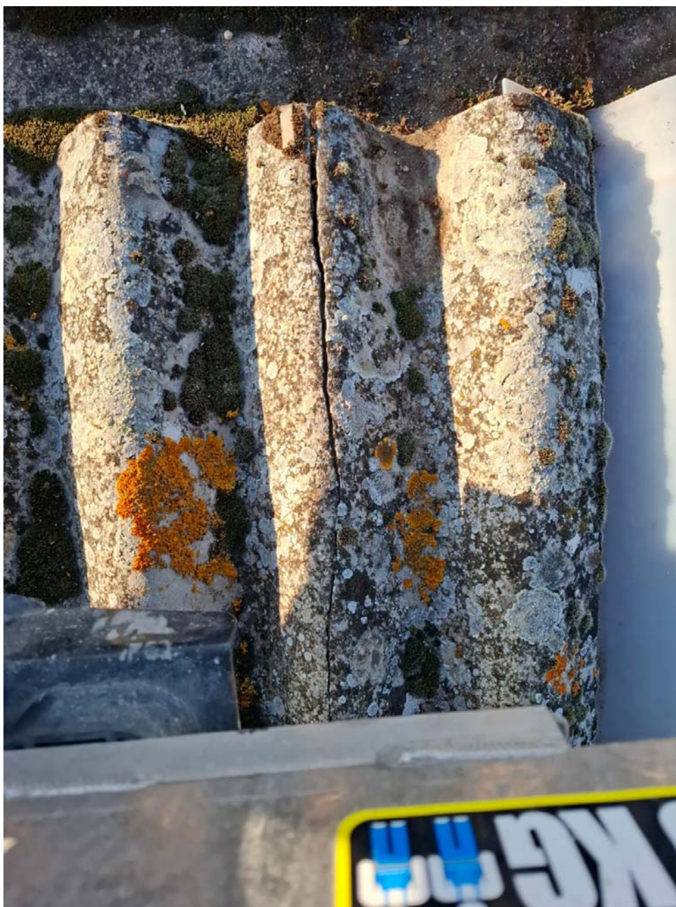
FOTO della rottura della lastra do copertura
