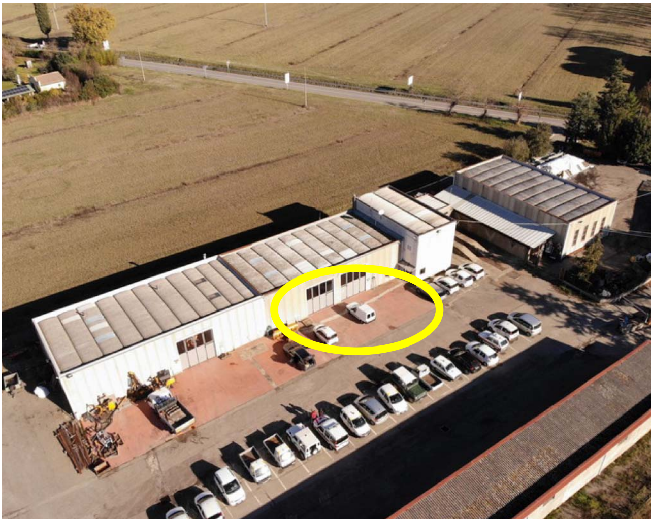
FOTO DALL'ALTO CON L'INDICAZIONE DEL POSIZIONAMENTO DELL'AREA DI CANTIERE ESTERNA
