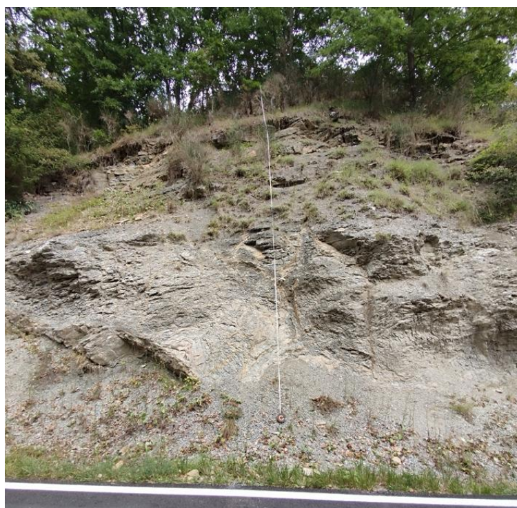
Figura 3-5. Misura dello sviluppo verticale della scarpata sud.
