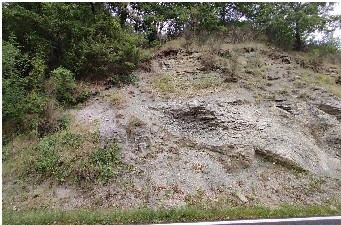
Figura 3-6. Foto frontale della scarpata Sud. Si notino l'abbondante vegetazione arbustiva e le querce presenti in sommità alla scarpata, da rimuovere prima di procedere col rivestimento della parete.
