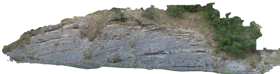
Figura 3-2. Ortofoto della scarpata nord.
