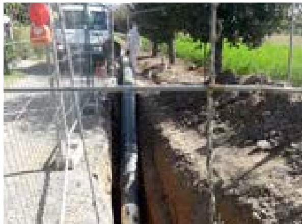
Figura 13: Lavori condotte di adduzione all'impianto di potabilizzazione Belvedere, Comune di Monte San Savino
