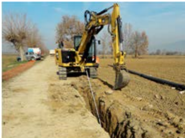
Figura 13: Lavori condotte di adduzione all'impianto di potabilizzazione Belvedere, Comune di Monte San Savino
