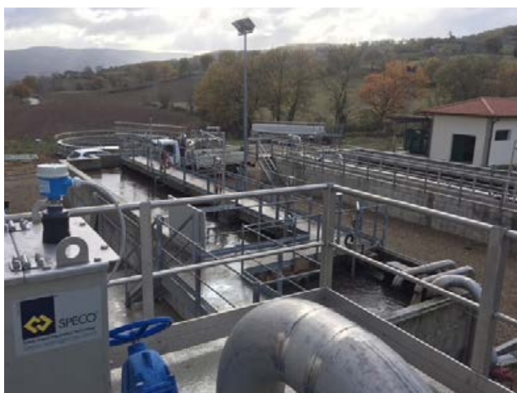
Figura 18: Ampliamento impianto di depurazione di Buiano, Comune di Poppi
