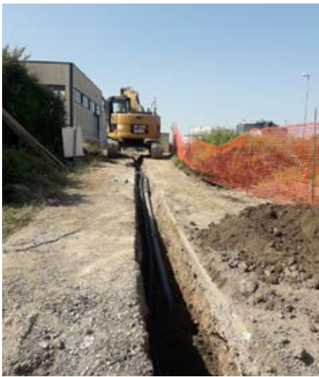
Figura 23: Lavori collettori fognari Cozzano basso, Comune di Castiglion Fiorentino
