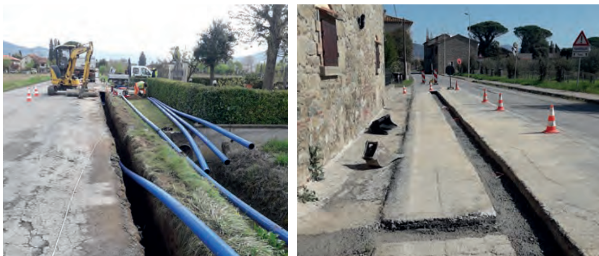
Figura 13: Estensione rete idrica Loc. La Nave, Comune di Castiglion Fiorentino
