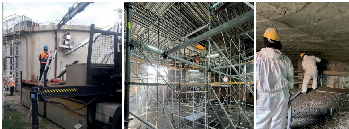
Figura 23: Revamping impianto di depurazione Casolino, Arezzo. Lavori lotto 1 - Rinnovo digestori anaerobici esistenti
