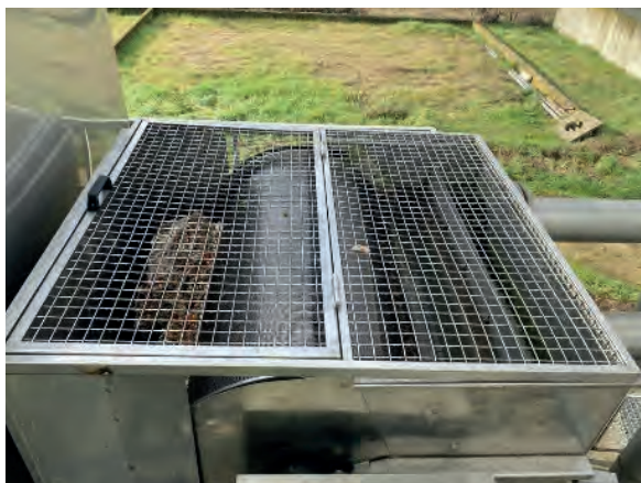
Impianto di depurazione Torrita di Siena: sostituzione del carter di protezione delle due grigli fini di impianto
