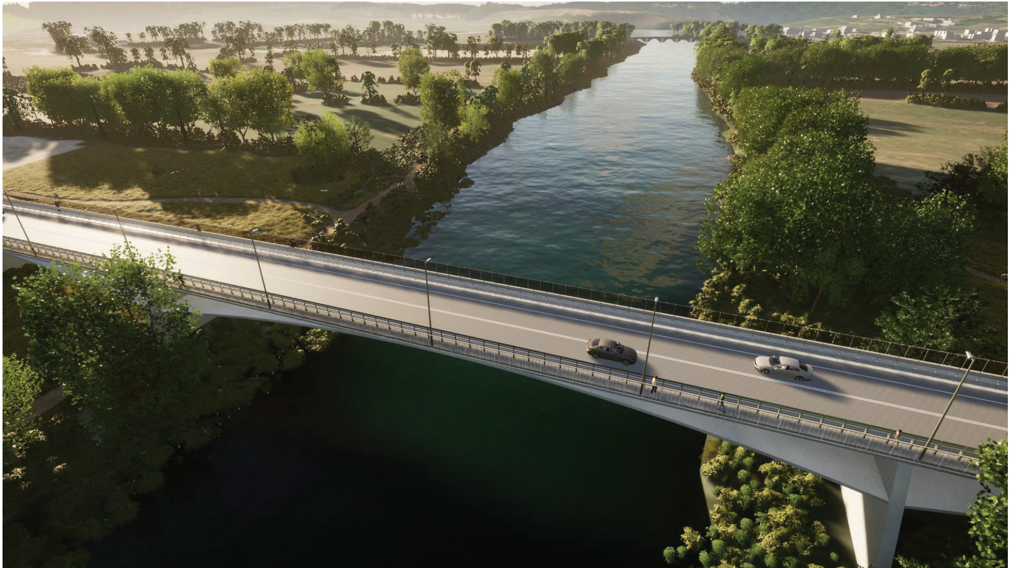
Figura 37. Vista aerea del nuovo attraversamento sul fiume Arno. Un marciapiede è destinato a lavori di manutenzione, l'altro (con affaccio verso ponte Buriano) permette il transito di pedoni e ciclisti.
