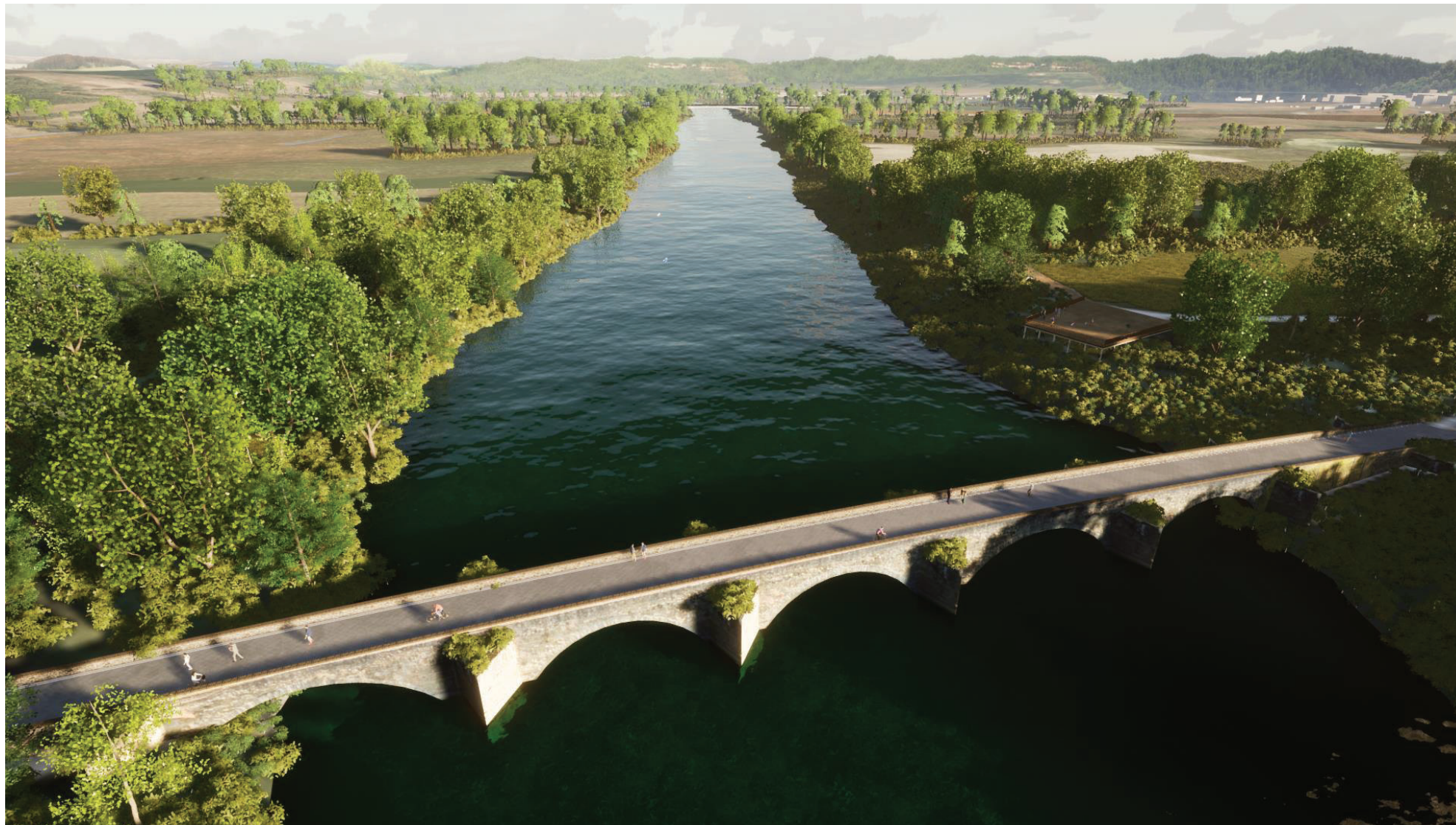
Figura 35. Vista aerea del ponte Buriano. A destra si mostra il nuovo belvedere e sullo sfondo si intravede il nuovo attraversamento
