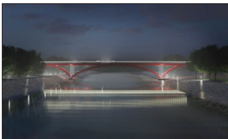
Vista notturna del nuovo ponte dall'Arno
