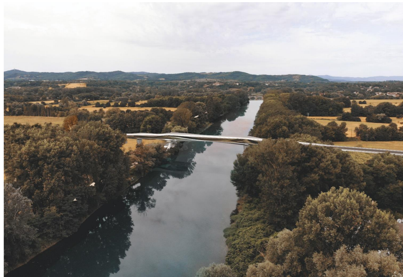
Figura 2 – Vista del nuovo ponte, Ponte Buriano sullo sfondo
