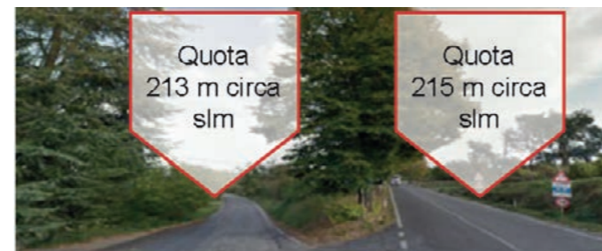
Dislivello tra la S.P.n°1 e la Via Quarata 2, compensato con la geometria di rotatoria ovoidale qui ideata
