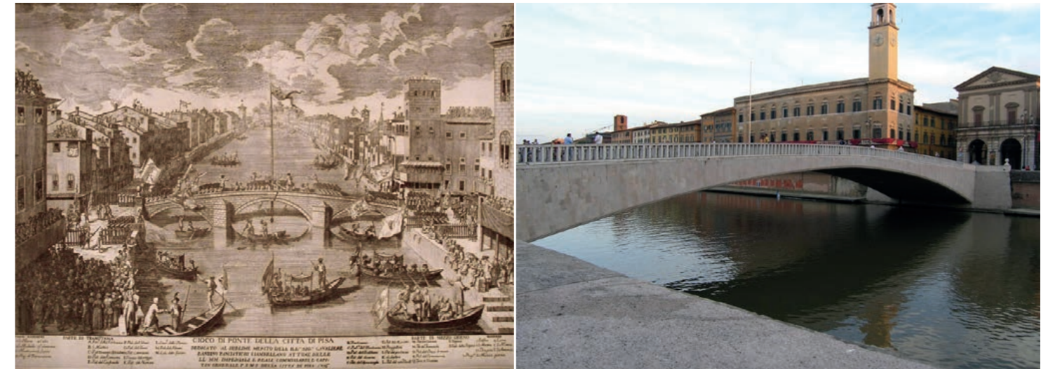
Il ponte di Mezzo a Pisa in una raffigurazione settecentesca e nella configurazione attuale
