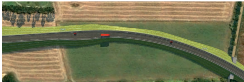
Andamento sinuoso del ciglio di piede scarpa di rilevato, che favorisce una configurazione naturomorfa eliminando la percezione di opera antropica del solido stradale
