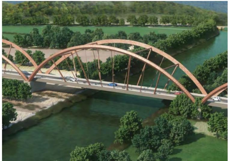
In particolare, per quanto riguarda le pile dell'arco di scavalco del fiume Arno, queste risulteranno posizionate al di fuori dell'alveo attivo del fiume, il cui **regime idraulico pertanto non verrà alterato dalla realizzazione del nuovo ponte**.
