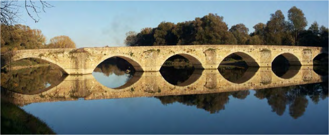
Figura 1-1 – Ponte a Buriano
