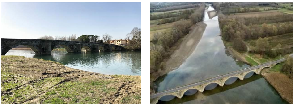
Fig. 3 – Inquadramento fotografico "Ponte Buriano"
