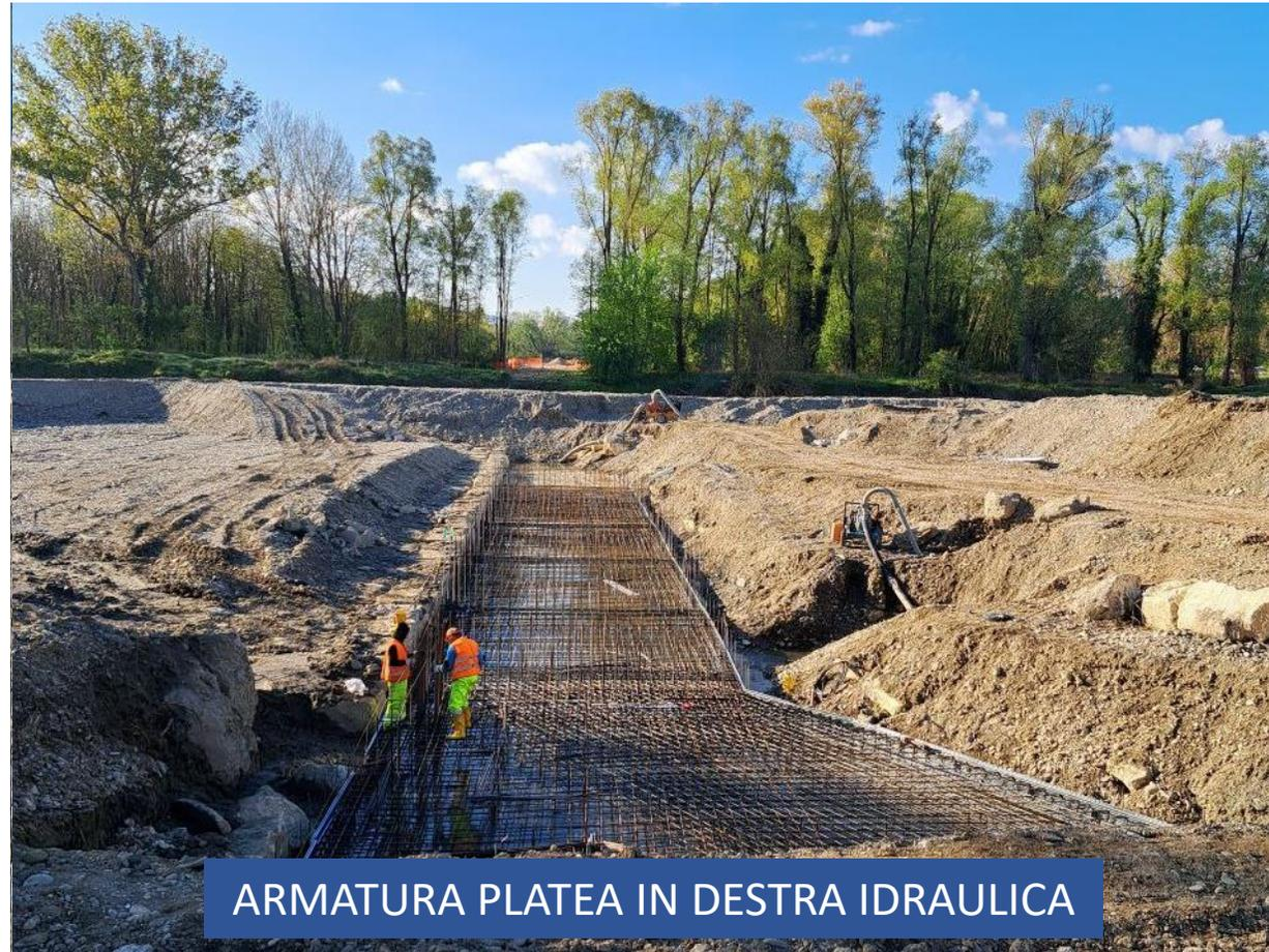
ARMATURA PLATEA IN DESTRA IDRAULICA
