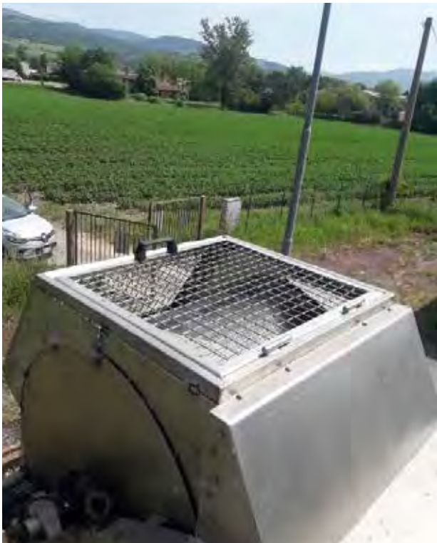
Impianto di depurazione Porrena Poppi Sostituzione del carter di protezione del rotostaccio
