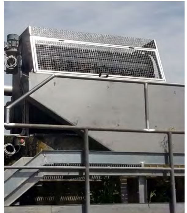
Impianto di depurazione Rassina Castel Focognano Sostituzione del carter di protezione del rotostaccio
