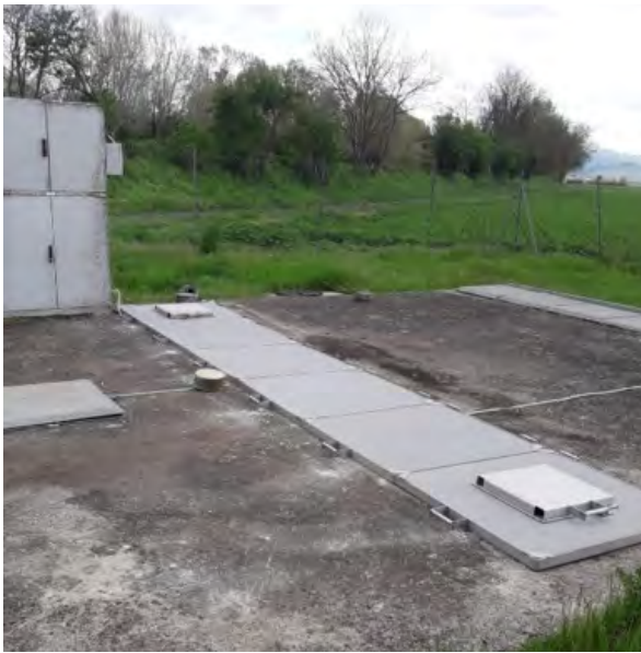
Sollevamento fognario S6 Pieve Santo Stefano: Sostituzione coperchi vasche
