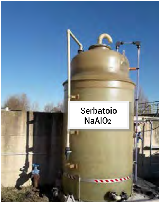
Impianto di depurazione Pian delle Torri (Chiusi) Adeguamento dello stoccaggio chimico di alluminato di sodio.
