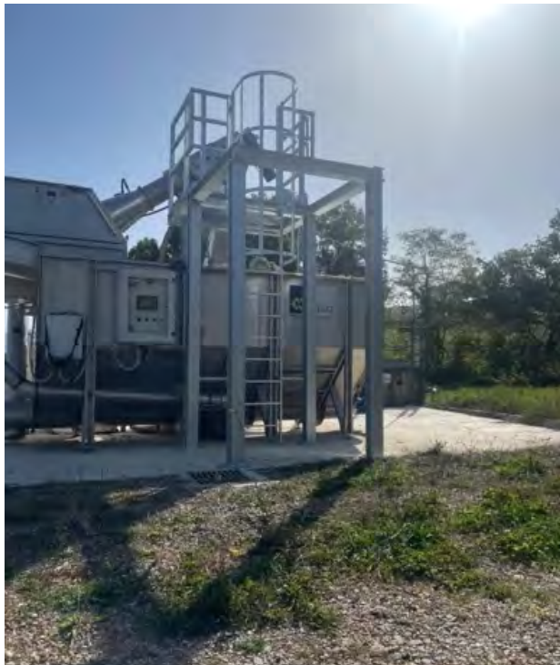
Impianto di depurazione Buiano (Poppi) Adeguamento macchinario trattamento extraflussi
