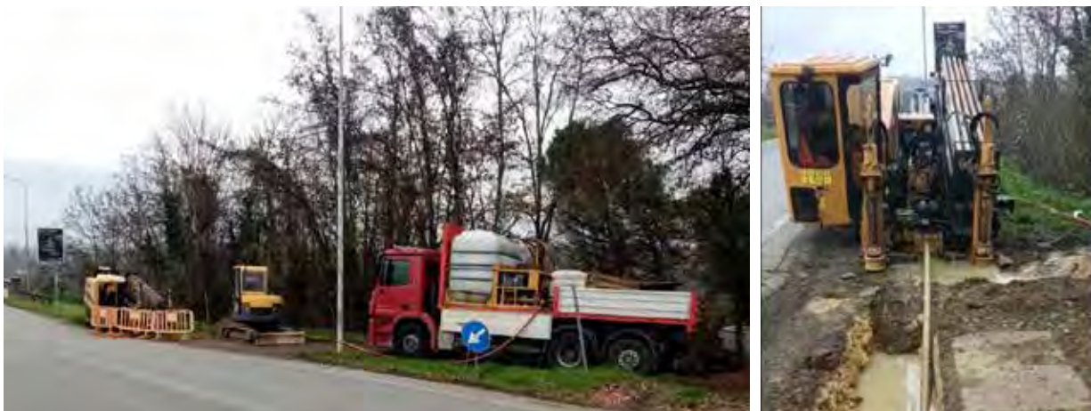
Figure 17 e 18: Lavori collegamento scarichi liberi nelle Loc. Pratantico
