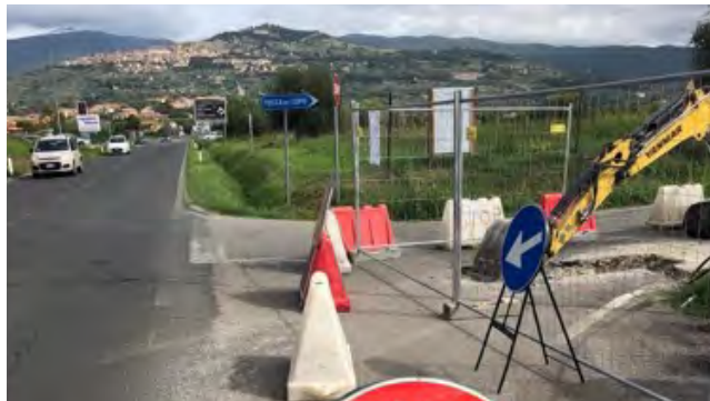
Figura 9: Lavori estensione idrica Loc. Fossa del Lupo, Comune di Cortona
