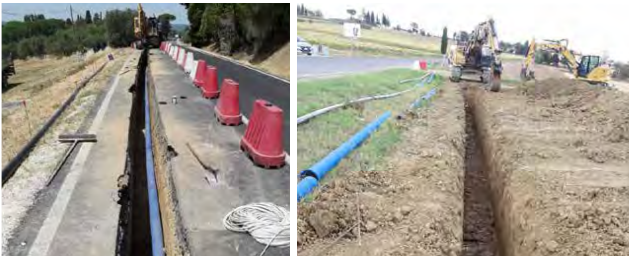
Figure 11 e 12: Lavori di condotta di adduzione/distribuzione da impianto di potabilizzazione Cesa a sollevamento Badicorte e da Badicorte a Loc. Torenna
