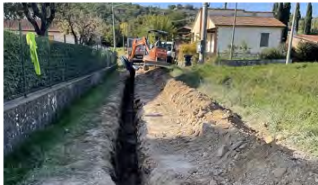
Figura 10: Lavori estensione idrica Loc. Rigomagno, Comune di Sinalunga
