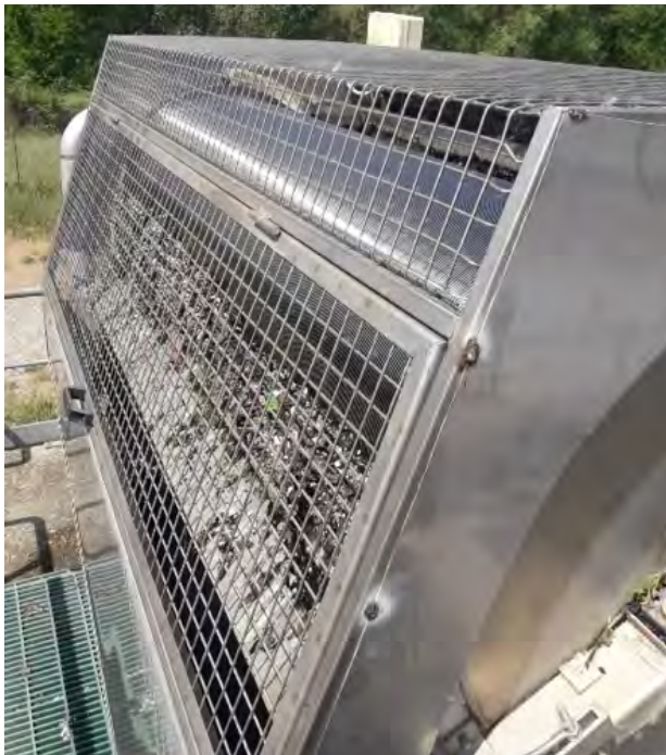
Impianto di depurazione Rassina Castel Focognano Sostituzione del carter di protezione del rotostaccio
