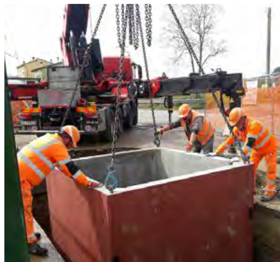
Figure 19 e 20: Lavori collegamento scarichi liberi Viale Santa Margherita e Via Buonconte da Montefeltro, Arezzo
