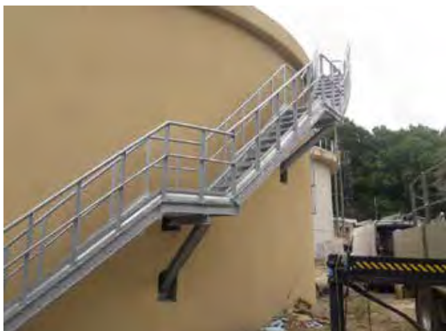
Scala a gradini per accesso al digestore presso l'impianto Casolino - Arezzo in sostituzione della scala tipo marinara con gabbia di protezione
