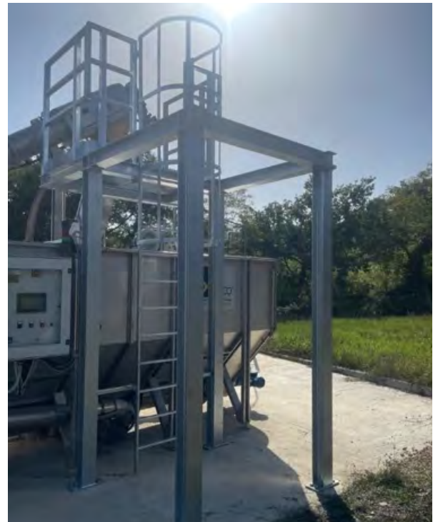
Impianto di depurazione Buiano (Poppi) Adeguamento macchinario trattamento extraflussi
