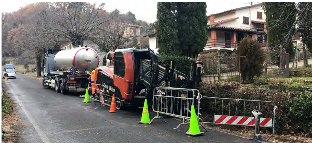
Figura 8: Lavori estensione idrica Loc. San Donato, Comune di Pratovecchio Stia
