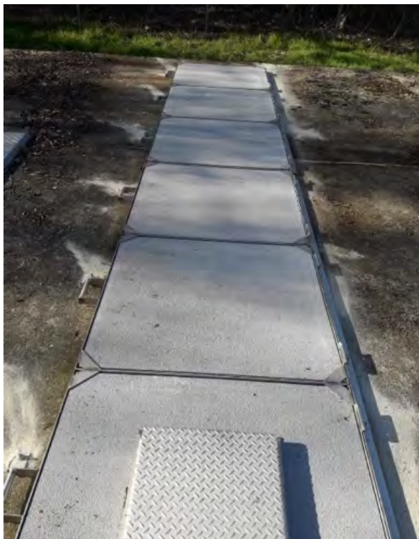
Sollevamento fognario S4 Pieve Santo Stefano Sostituzione coperchi vasche
