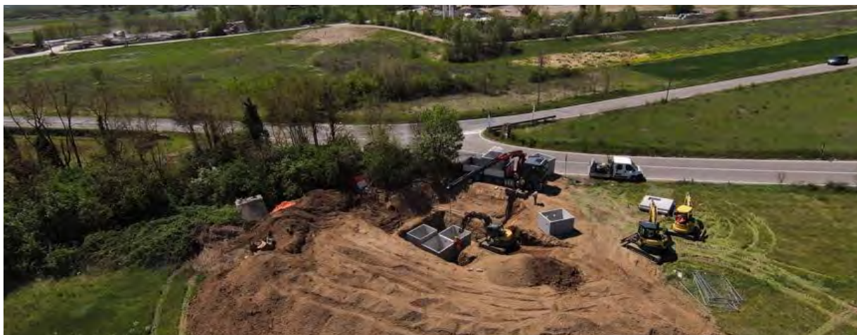
Figura 15: Realizzazione impianto di sollevamento fognario in Loc. Patrignone, Comune di Arezzo
