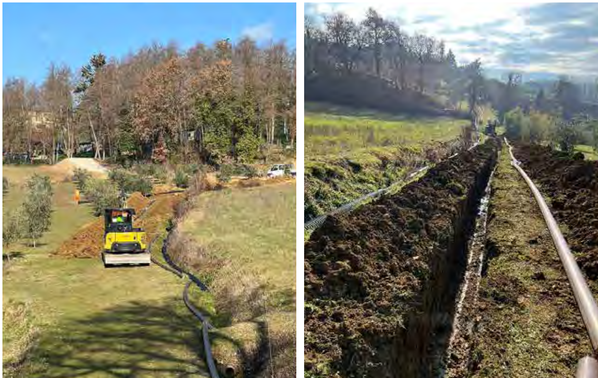
Figure 13 e 14: Completamento del collegamento alla depurazione dell'agglomerato di Anghiari
