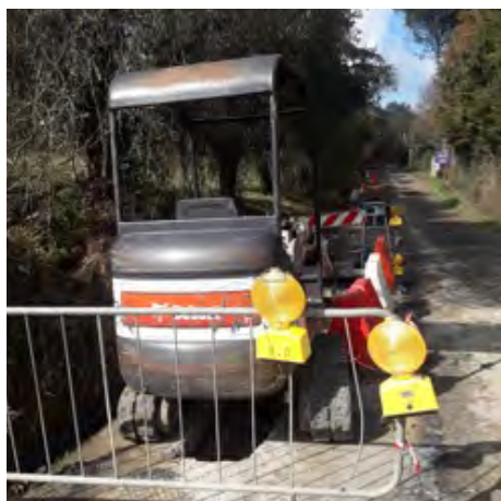
Figura 5: Lavori estensione idrica Loc. Le Selve, Comune di Foiano della Chiana
