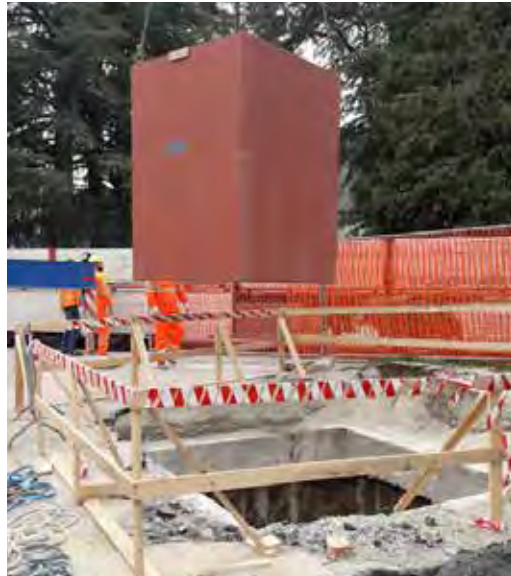
Figura 16: Lavori completamento del collegamento alla depurazione dell'agglomerato di Pieve Santo Stefano
