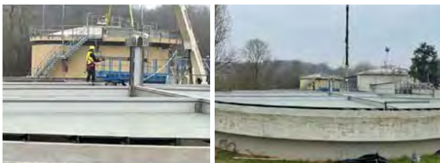
Figure 33 e 34: Revamping impianto di depurazione Casolino, Arezzo. Lavori lotto 2 - montaggio copertura sedimentatore primario
