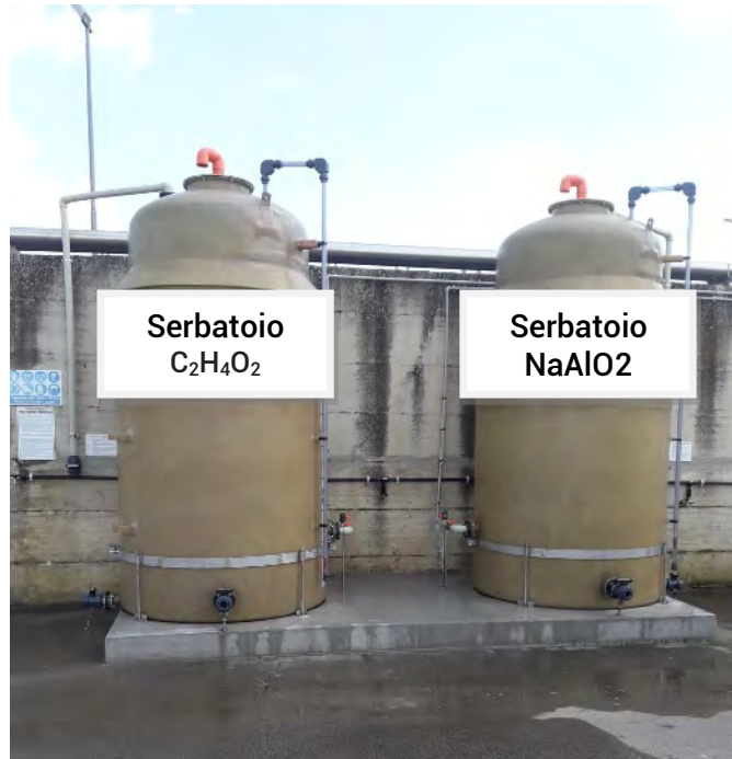
Impianto di depurazione Corbaia (Montepulciano) Adeguamento dello stoccaggio chimico di acido acetico e alluminato di sodio.
