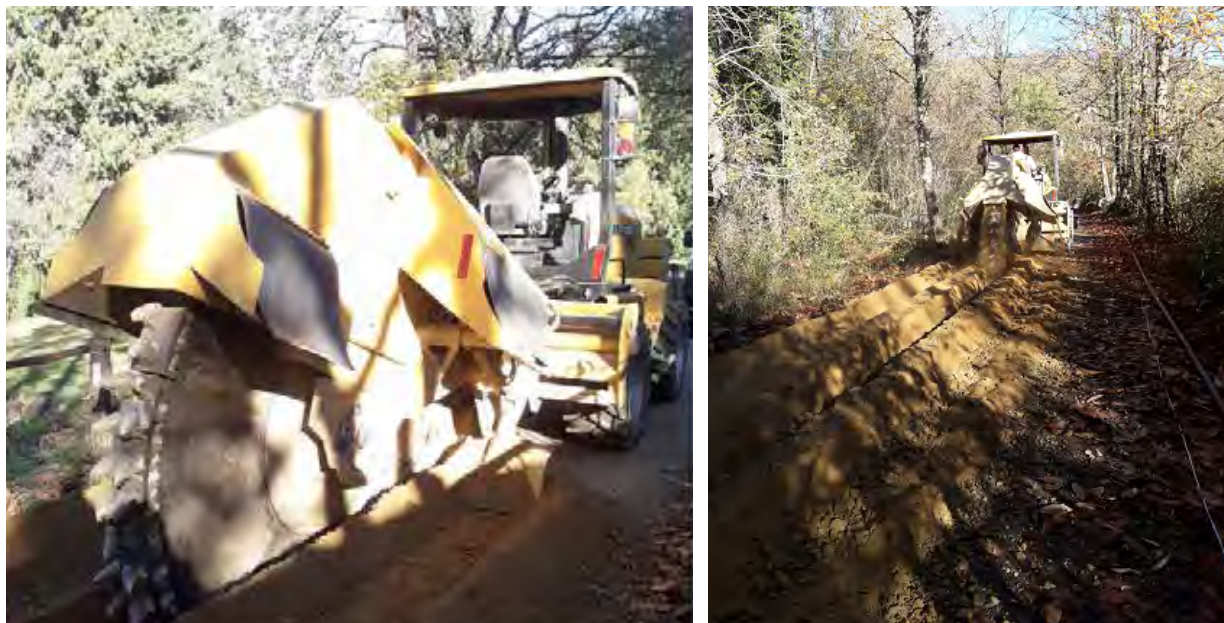
Figure 6 e 7: Lavori estensione idrica Loc. Balestro, Comune di Castel Focognano
