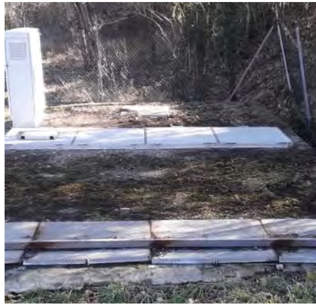
Sollevamento fognario S1 Pieve Santo Stefano Sostituzione coperchi vasche
