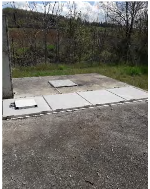
Sollevamento fognario S5 Pieve Santo Stefano Sostituzione coperchi vasche
