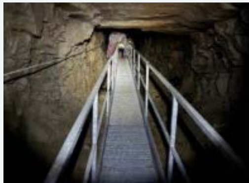
Foto 2: dettaglio della passerella in acciaio che collega i due livelli principali di quota dei tunnel
