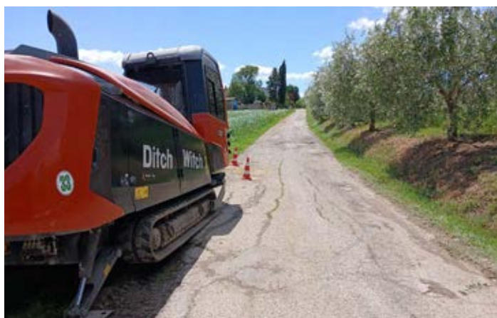
Figura 1: Estensione idrica Loc. Creti, Comune di Cortona
