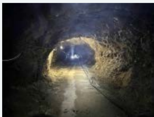
Foto 3: tunnel di accesso principale (primo livello di profondità)
