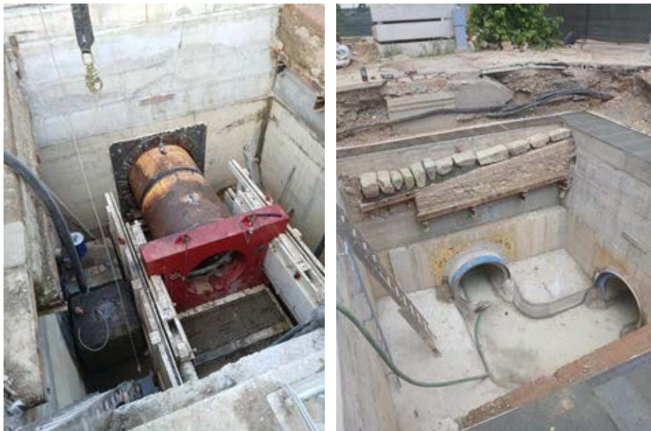
Figure 11 e 12: Lavori Via Romana Lotto 2, Comune di Arezzo
