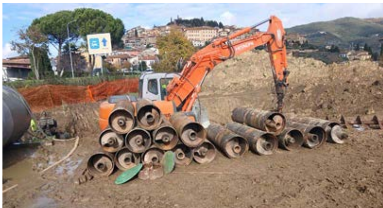
Figura 10: Lavori collegamento scarichi liberi Castiglion Fiorentino
